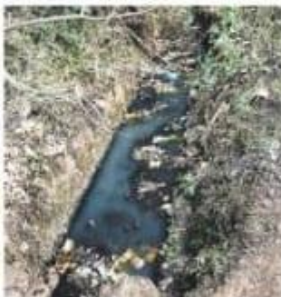
Agua estancada y hasta ratas abundan por este sector, que requiere una pronta intervención.
