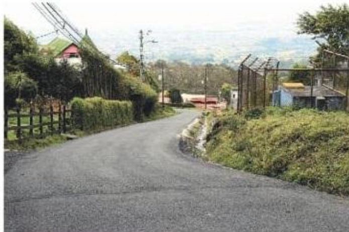
Aquí quedó la calle del empedrado una vez que se le colocó asfalto por arriba.
