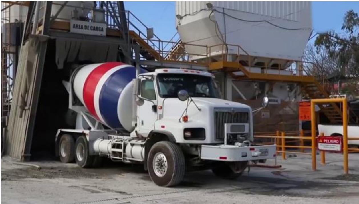
Figura 51 Área de carga de una planta de concreto
