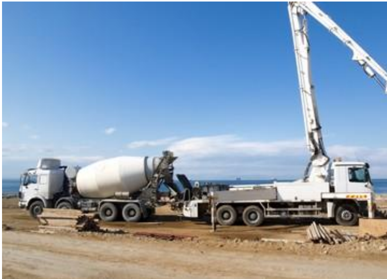
Figura 52 Mixer y Bomba de concreto
