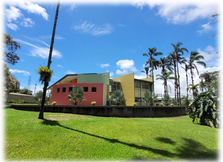
Imagen 16. Nuevo Edificio de Investigación.
