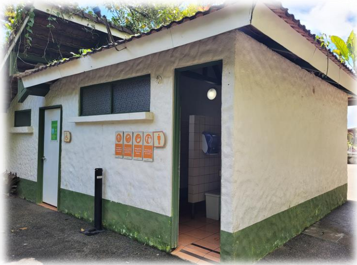
Imagen 5. Servicio Sanitario para hombres.
