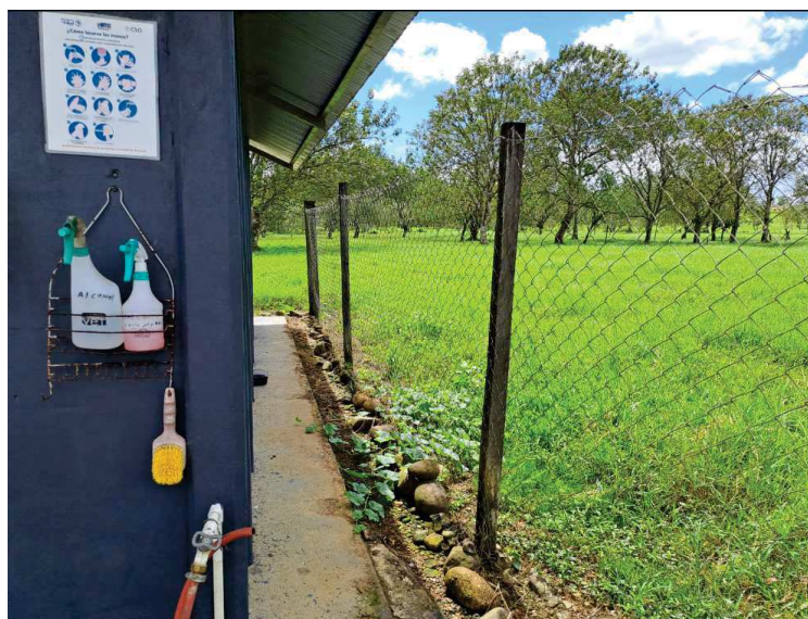
Figura 16. Maya perimetral Granja Los Negritos
