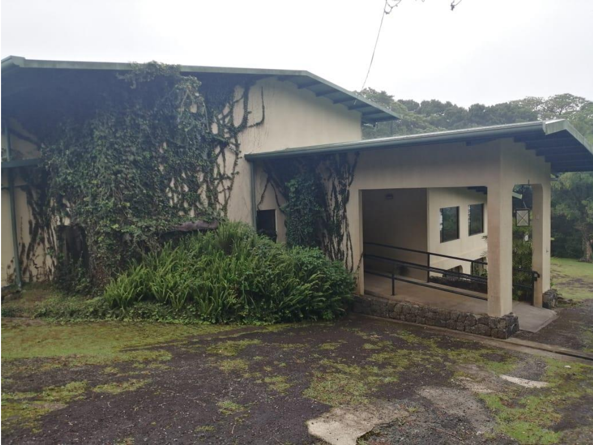
Vista desde el portón de acceso a la casa que funcionará como recepción y oficinas.
