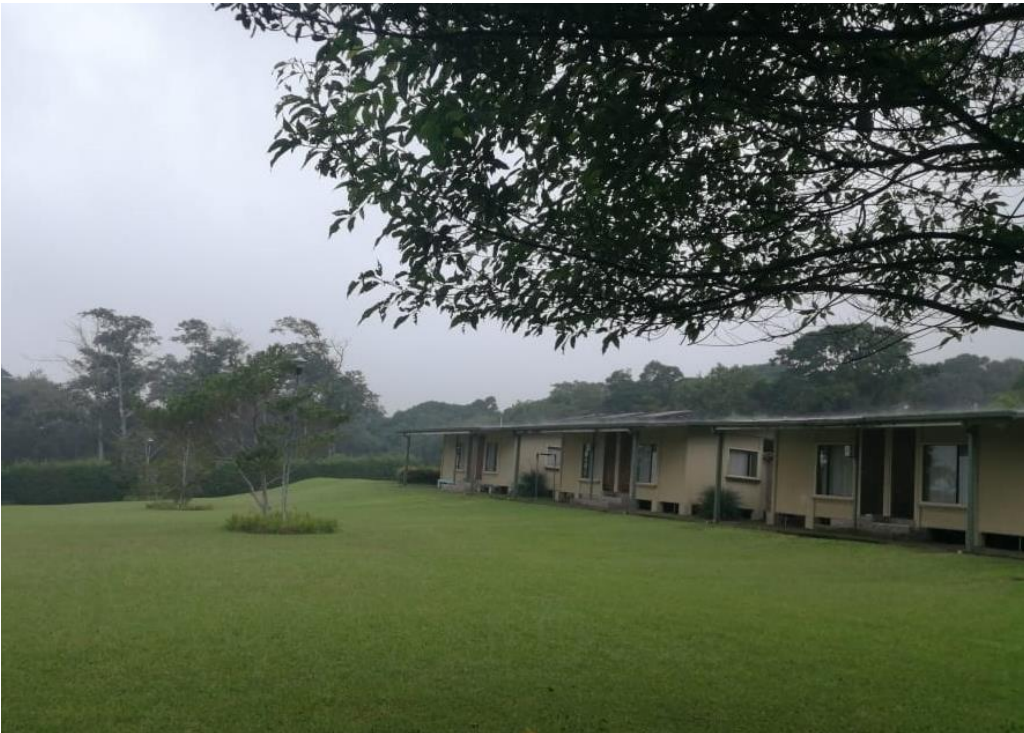
Vista trasera de apartamentos que funcionarán como cabinas
