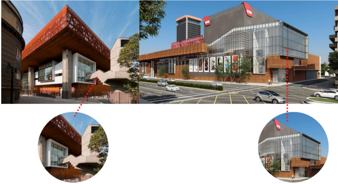
Figura 13: Puente exterior y piel de cristal, GAM, Chile. Fuente: Elaboración propia
