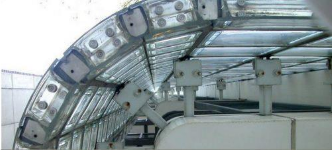
Figura 36: Vista detallada de piel de vidrio. Fuente: Arquitectura Viva
