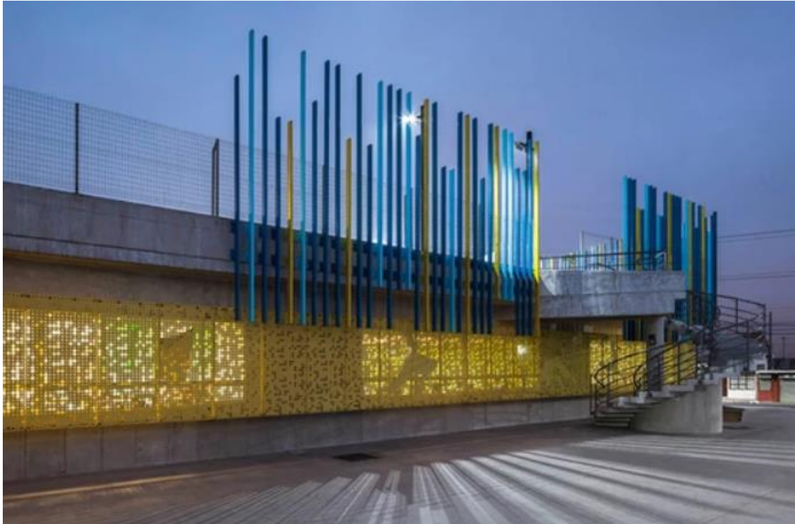
Figura 24: Piel del exterior, CCP Cartago. Fuente: Norte Sur arquitectos
