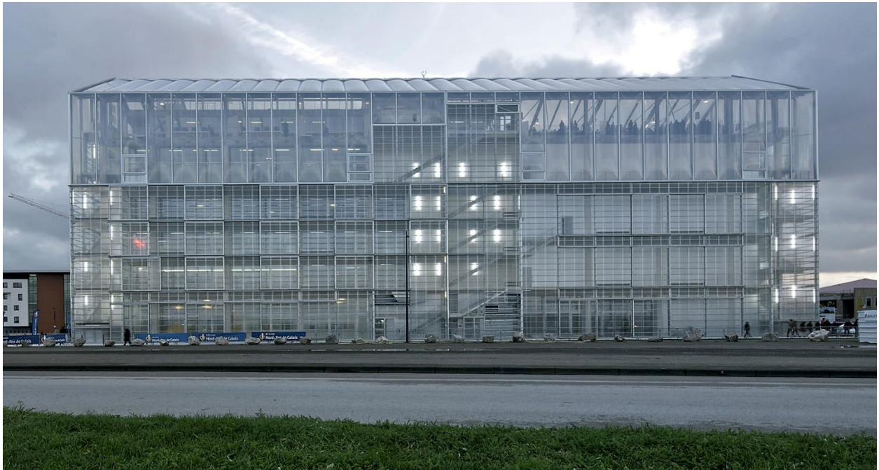
Figura 28: Vista exterior, FRAC Dunkerque. Fuente: Ruault, P
