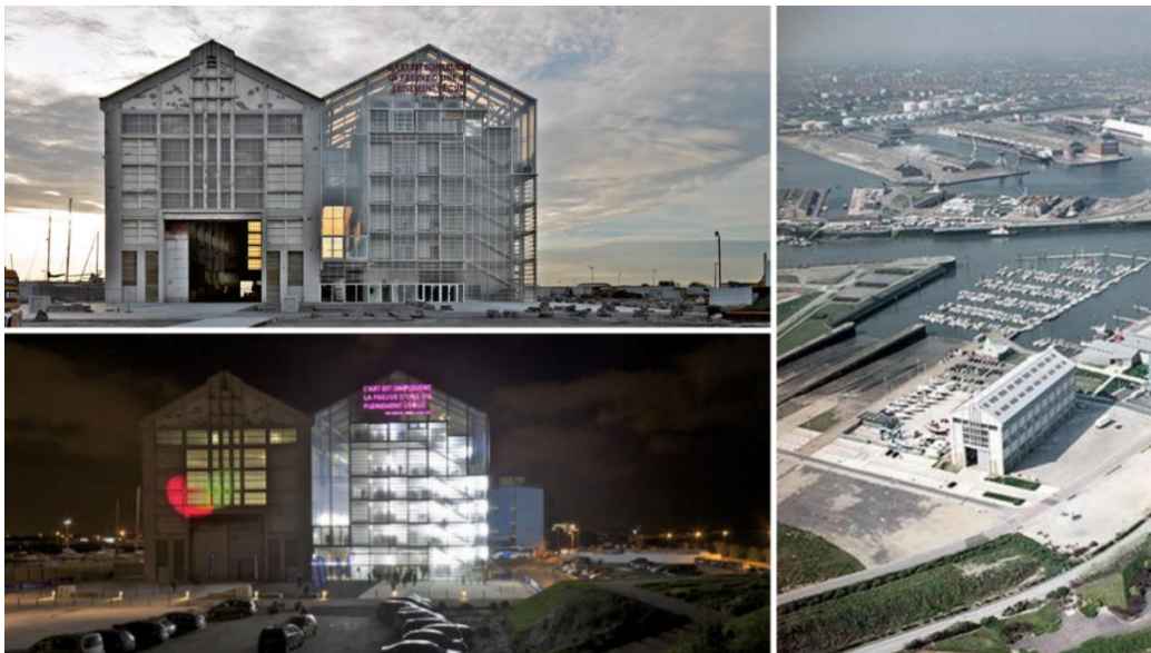
Figura 25: FRAC, Dunkerque, Francia. Fuente: Ruault, P
