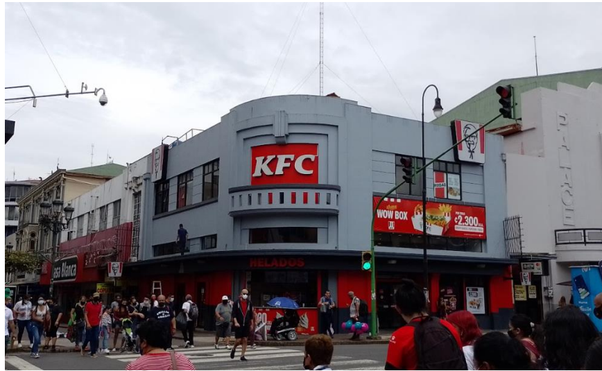
Figura 89: Antigua Soda Palace en 2022. Fuente: Propia
