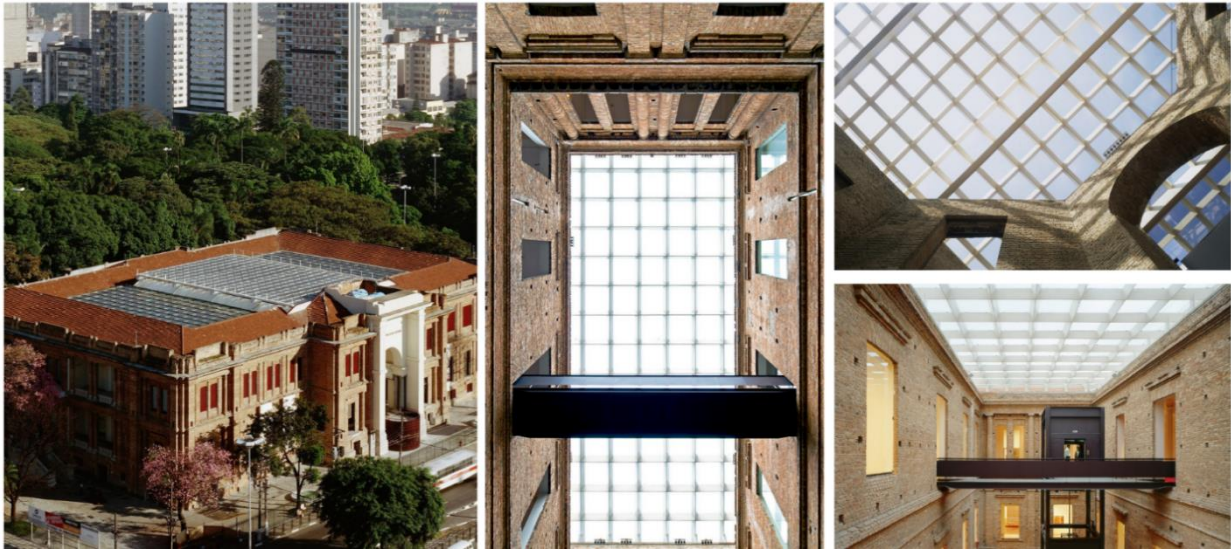
Figura 30: Vistas de la cubierta, Pinacoteca de Sao Paulo. Fuente: Plataforma Arquitectura
