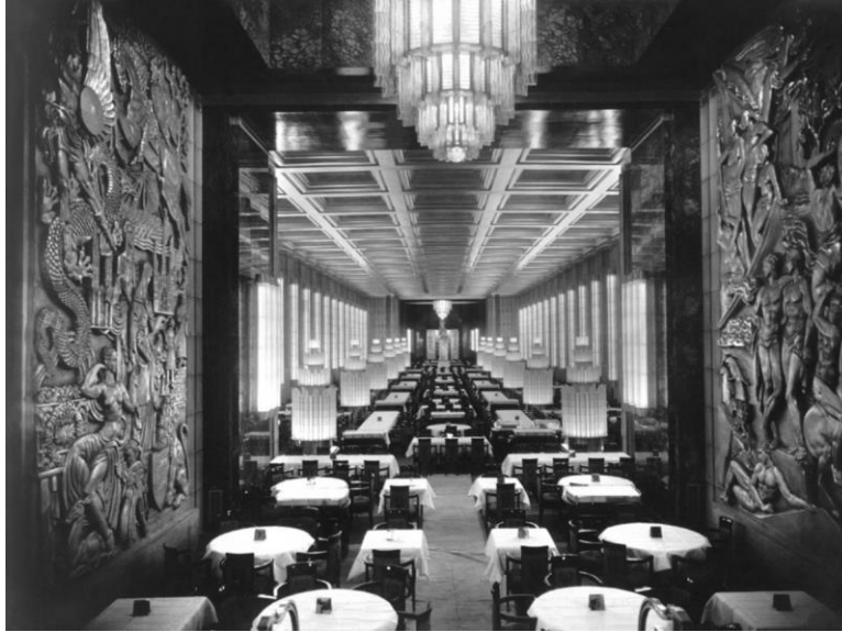
Figura 61: Interior de Salón Art Déco. Fuente: Wordpress
