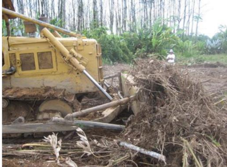
Figura 3: Limpieza de terreno
