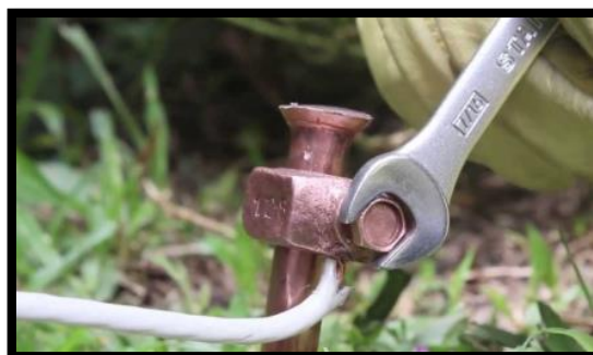
Ilustración 7 Puesta a tierra
