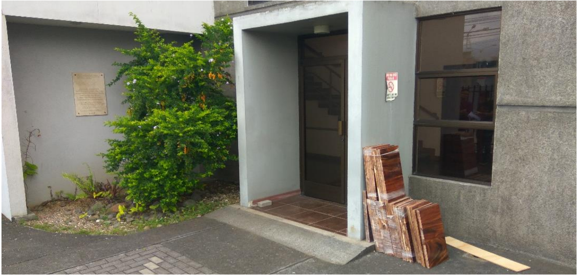
Figura N° 14. Zona para la instalación del tanque
