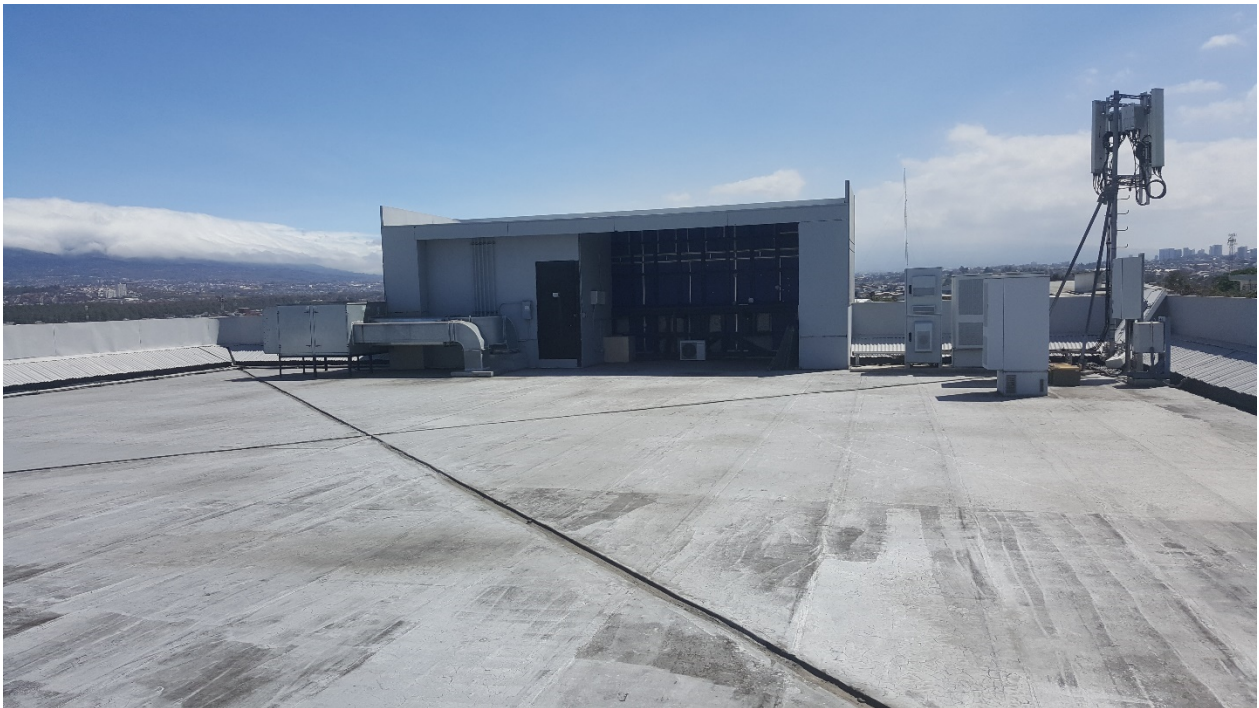
Figura 17. Vista frontal de la azotea
