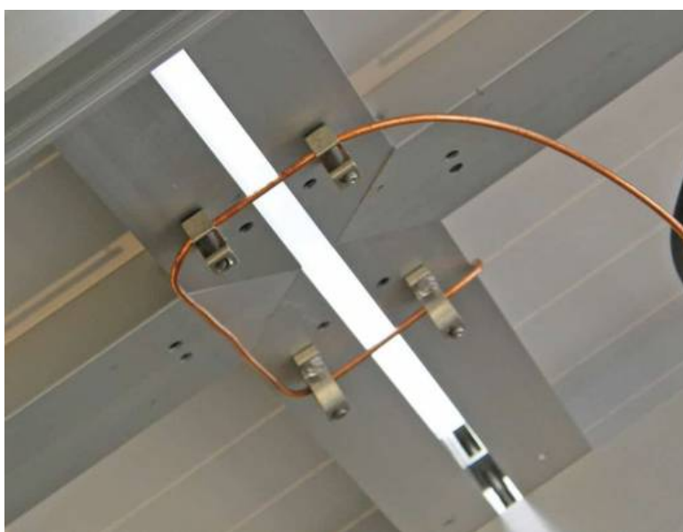
Figura 11. Diagrama de puesta a tierra de panel fotovoltaico
