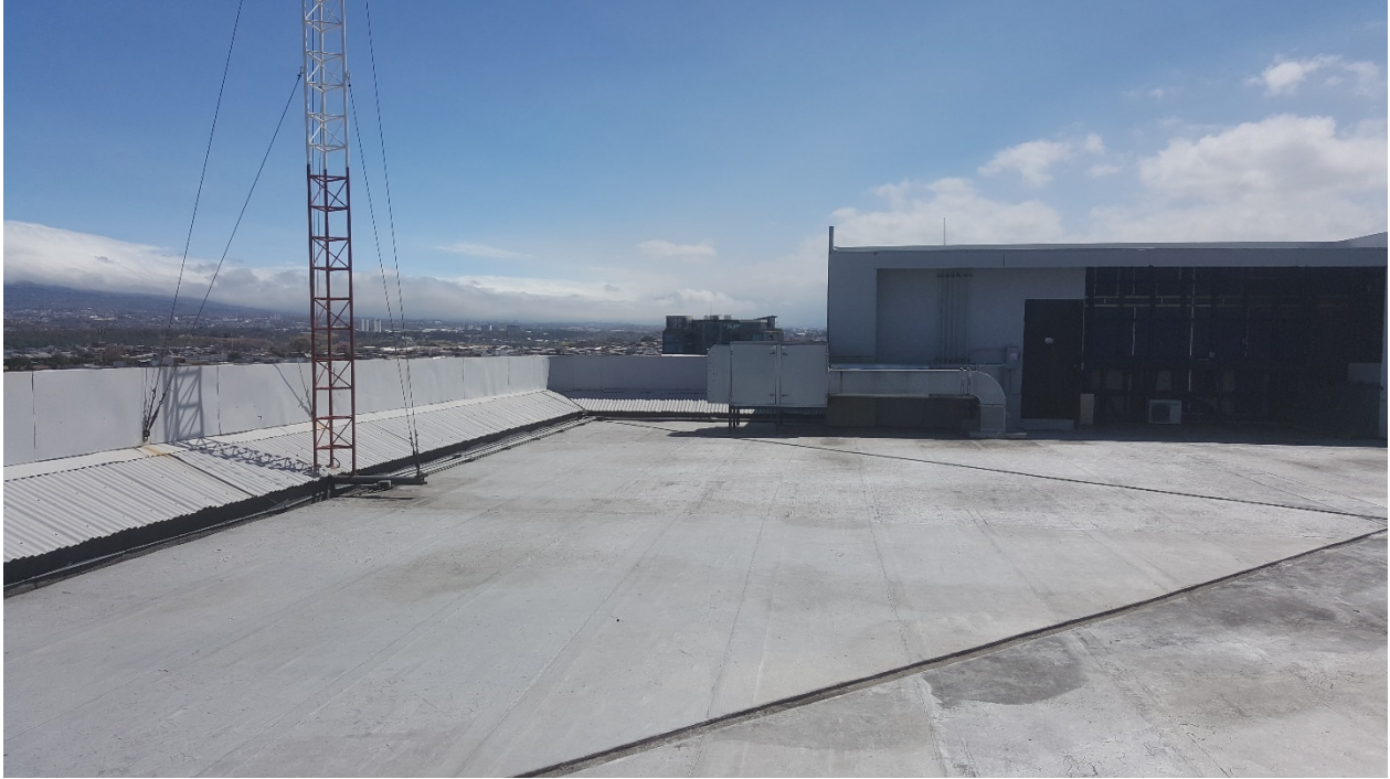
Figura 16. Vista 1 de azotea
