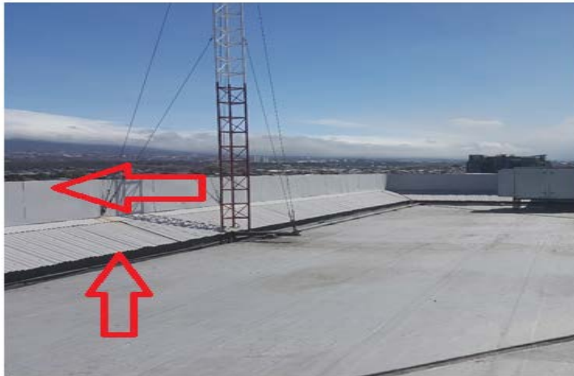
Figura 20. Murete y desagüe de la azotea
