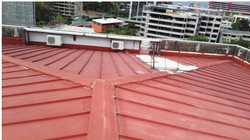
Figura 47: Techo utilizable para instalación de paneles.
