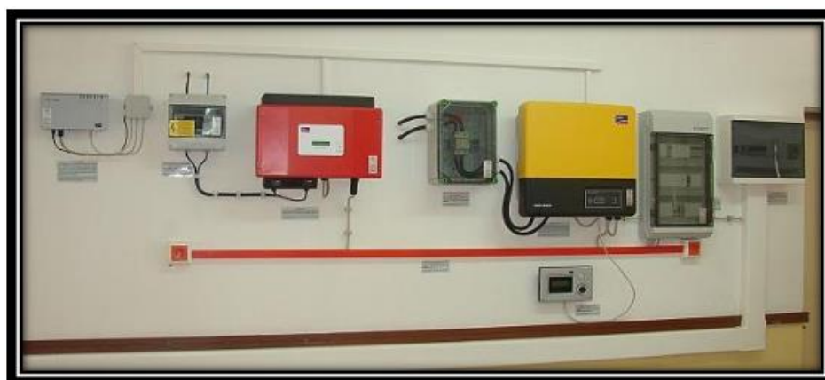
Ilustración 17. Dos inversores en un sistema acoplado en CA: un inversor-cargador(amarillo) y un inversor conectado a la red(rojo).
