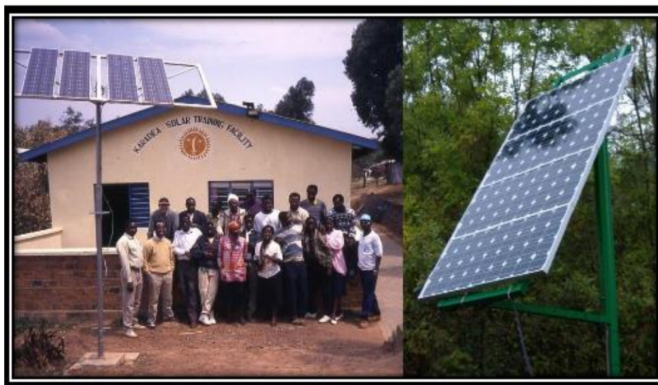
Ilustración 27. Izquierda: Estructura de seguimiento manual en centro de formación en Tanzania. Derecha: Módulos en un montaje en poste de fabricación local para un sistema de energía solar doméstico en la Francia rural. Ambas estructuras son hechas en hierro dulce y pintadas para su protección.
