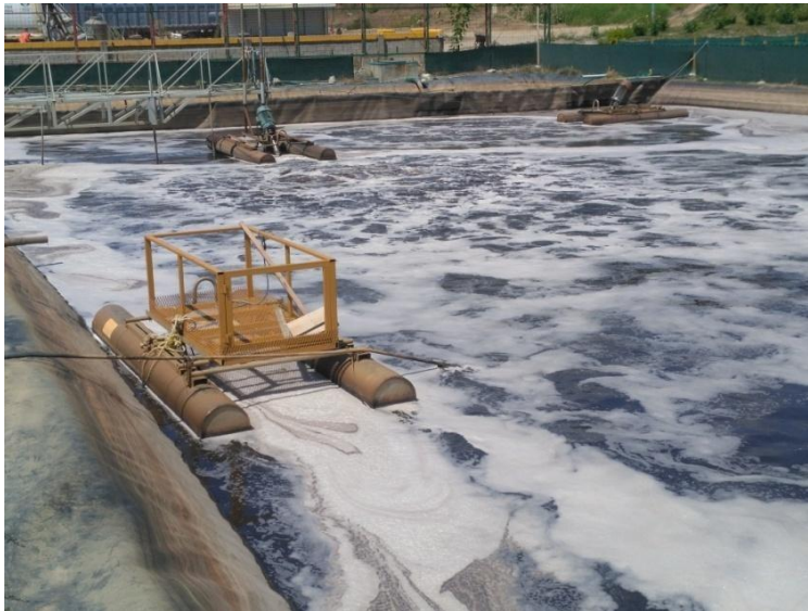
Ilustración 18 Balsa utilizada para la ejecución de mantenimientos.
