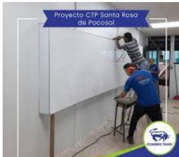
Figura 37 Proceso de instalación
