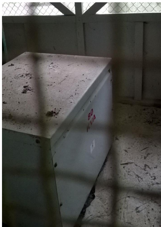
Ilustración 4.6: Transformador seco de 80KVA
