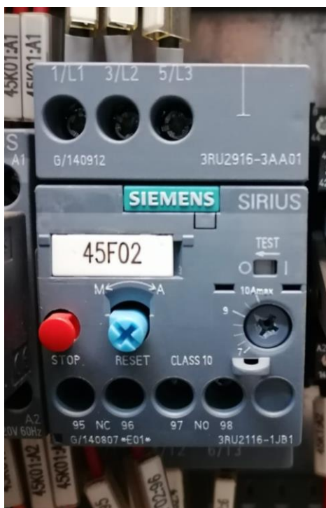
Figura 51. Figura desarrollo 13. Relé de sobrecarga SIEMENS 3RU2126-1JB1 regulable de 7 a 10 Amperios.
