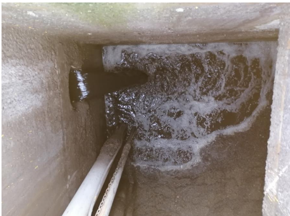
Figura 40. Figura Desarrollo 2. Entrada de vaciados al pozo.
