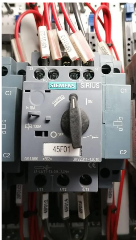
Figura 49. Figura desarrollo 11. Guarda motor SIEMENS de corriente nominal 10 Amperios y disparador 130 Amperios modelo 3RV2311-1JC10 o similar.
