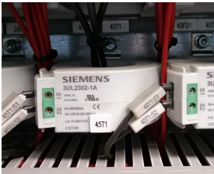
Figura 50. Figura desarrollo 12. Transformador diferencial para vigilancia de corriente SIEMENS 3UL2302-1 A.
