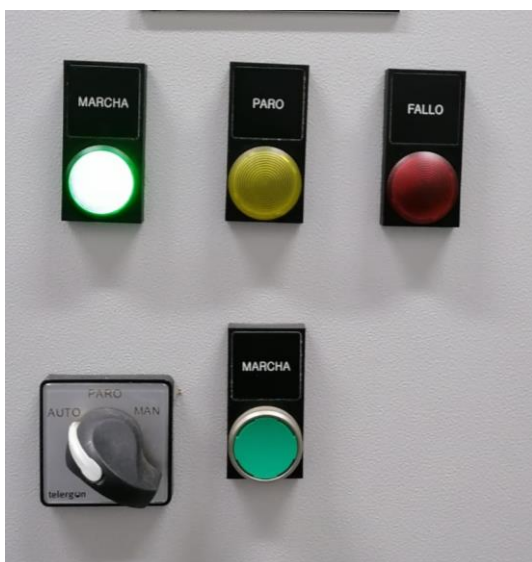
Figura 53. Figura desarrollo 15. Botonera e iluminación para utilizar en CCM 21.
