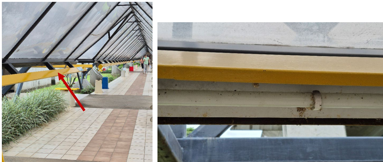
Ilustración 26. Iluminación de pasillos
