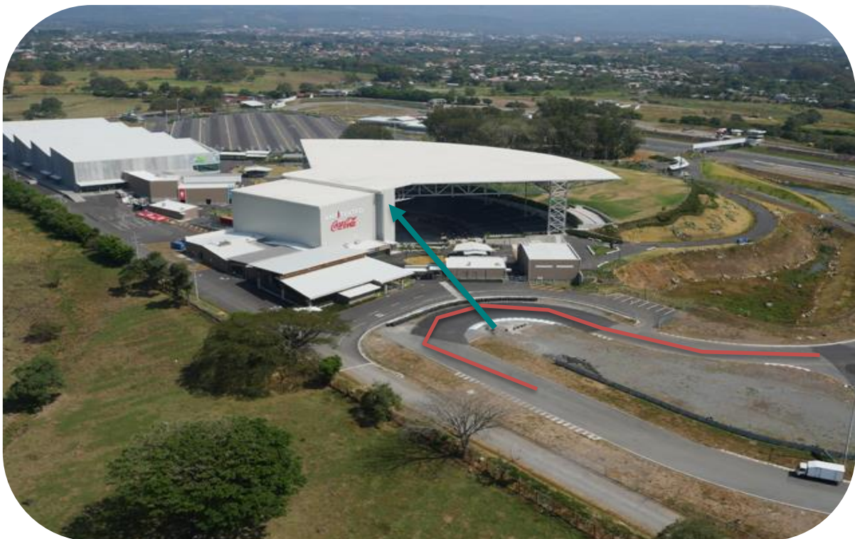
Recorridos con visuales a los diferentes recintos dentro del complejo arquitectónico
