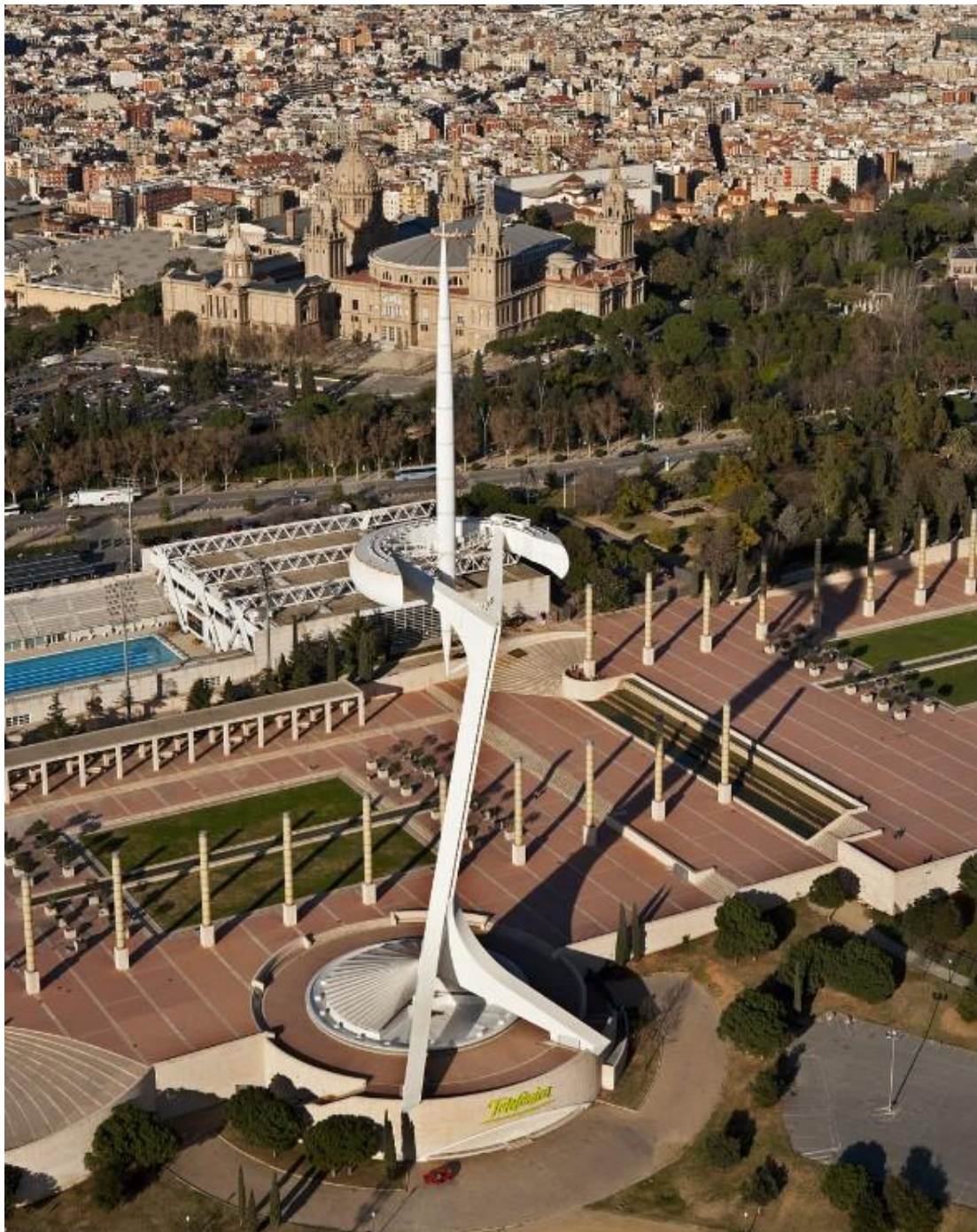
Ilustración 72 - Torre de Comunicaciones de Montjuïc
