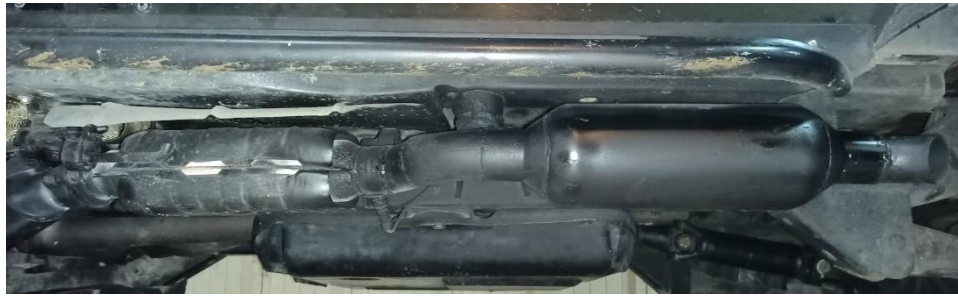
Imagen 56. Sistema de escape instalado
