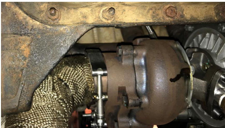
Imagen 37. Tubería de escape con aislante.
