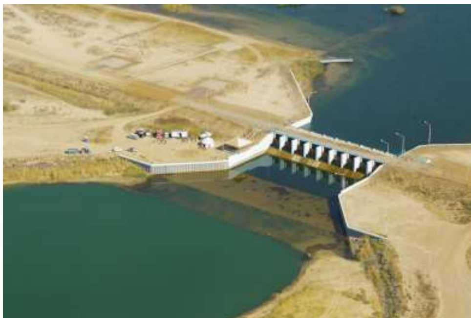
Figura 12. Instalación del proyecto Kokaral
