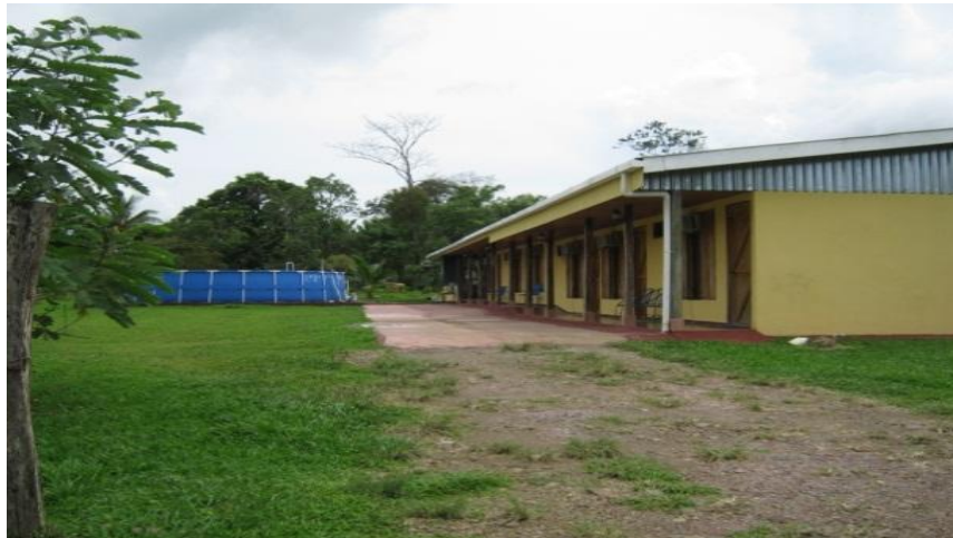
Figura # 22: Cabinas Las Nubes
