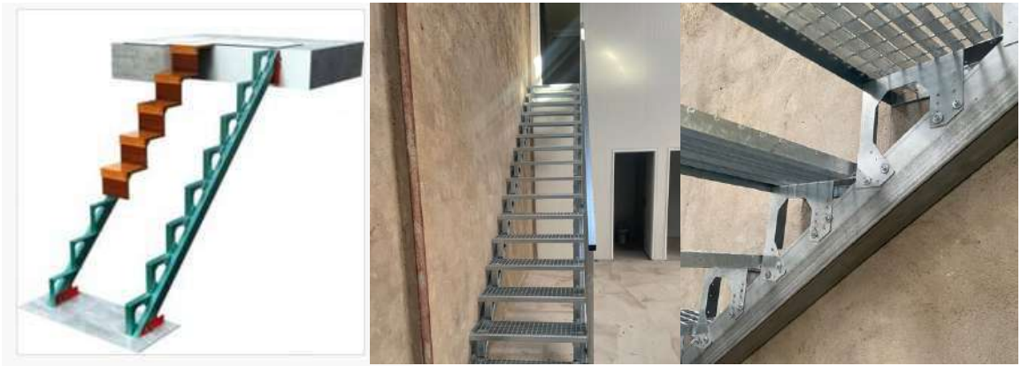
Figura C03- 27 Escaleras atornilladas para estructuras metálicas Fuente (StarModul)
