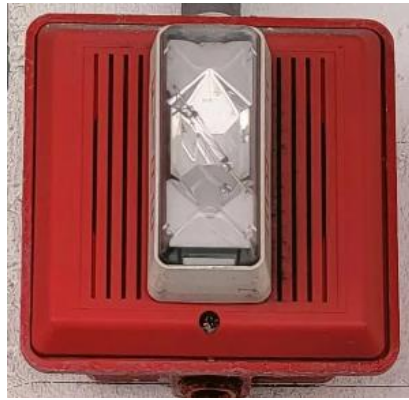
Imagen 13: Luz estroboscópica
