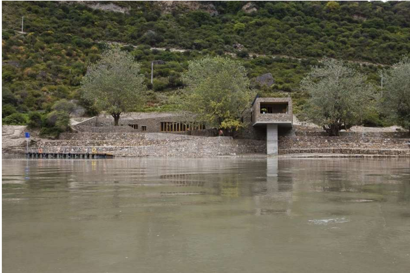
Imagen 3: Vista Frontal Terminal Náutica
