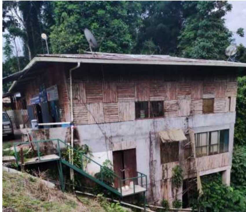
Imagen 36: Ferretería y taller junto a Casa de habitación
