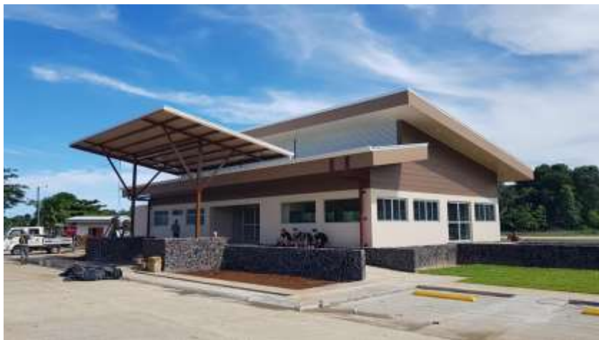
Imagen 25: Nueva Terminal y Aeropuerto de Bahía Drake
