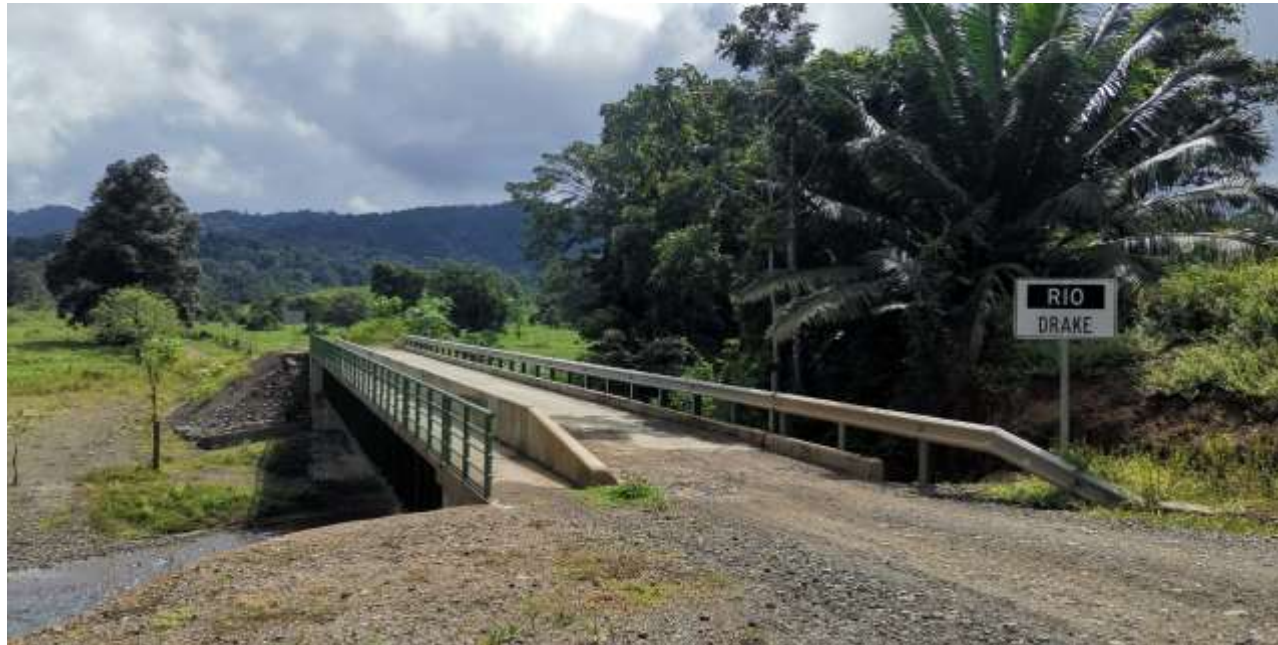
Imagen 23: Puente Río Drake construido en él . 2019. Antes de esta fecha el camino se cortaba en la época lluviosa, casi 8 meses al año incluyendo la temporada alta de la actividad turística.
