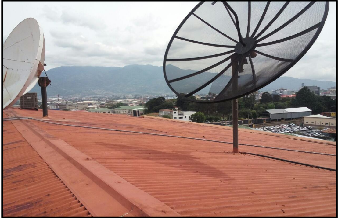
Figura 4: Vista suroeste del techo del edificio principal (zona 1)
