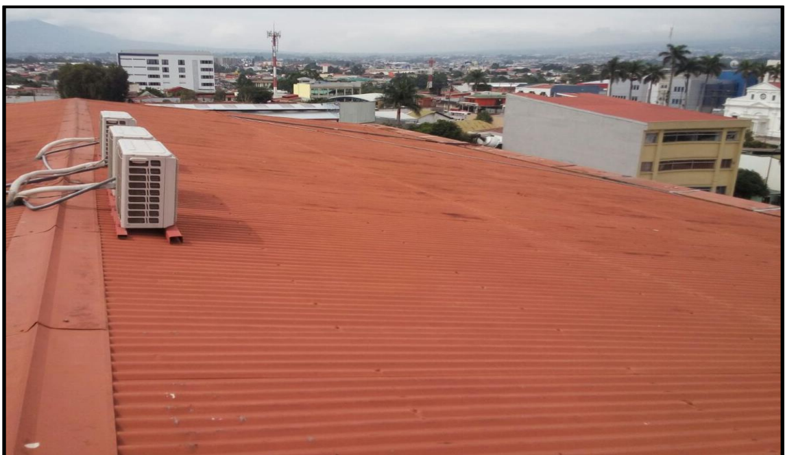
Figura 3: Vista noreste del techo del edificio principal (zona 1)
