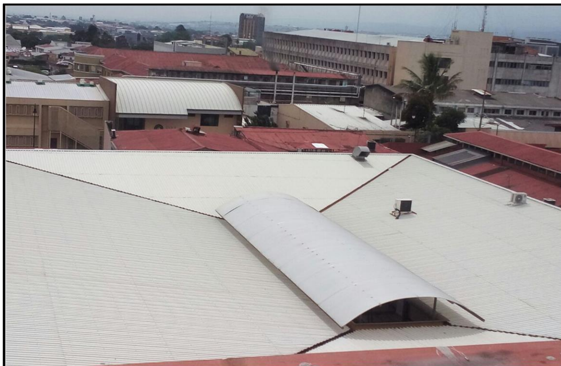
Figura 6: Vista frontal del techo del edificio anexo (zona 2)
