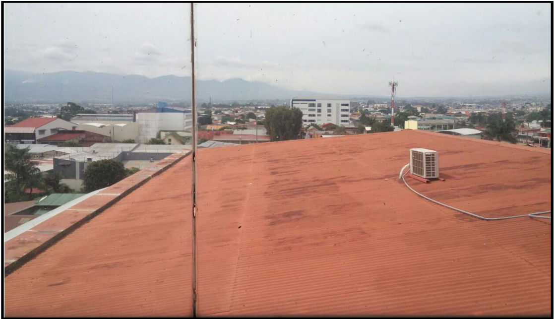
Figura 2: Vista noroeste del techo del edificio principal (zona 1)
