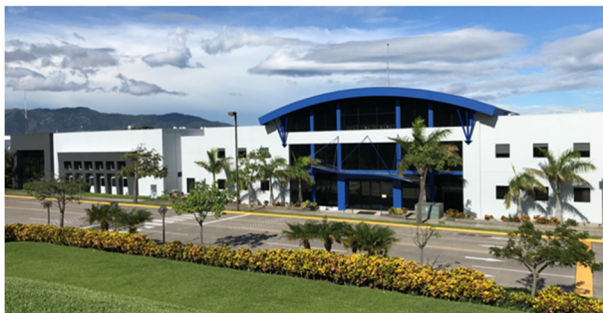
Figura 1. Instalaciones físicas de la empresa.
