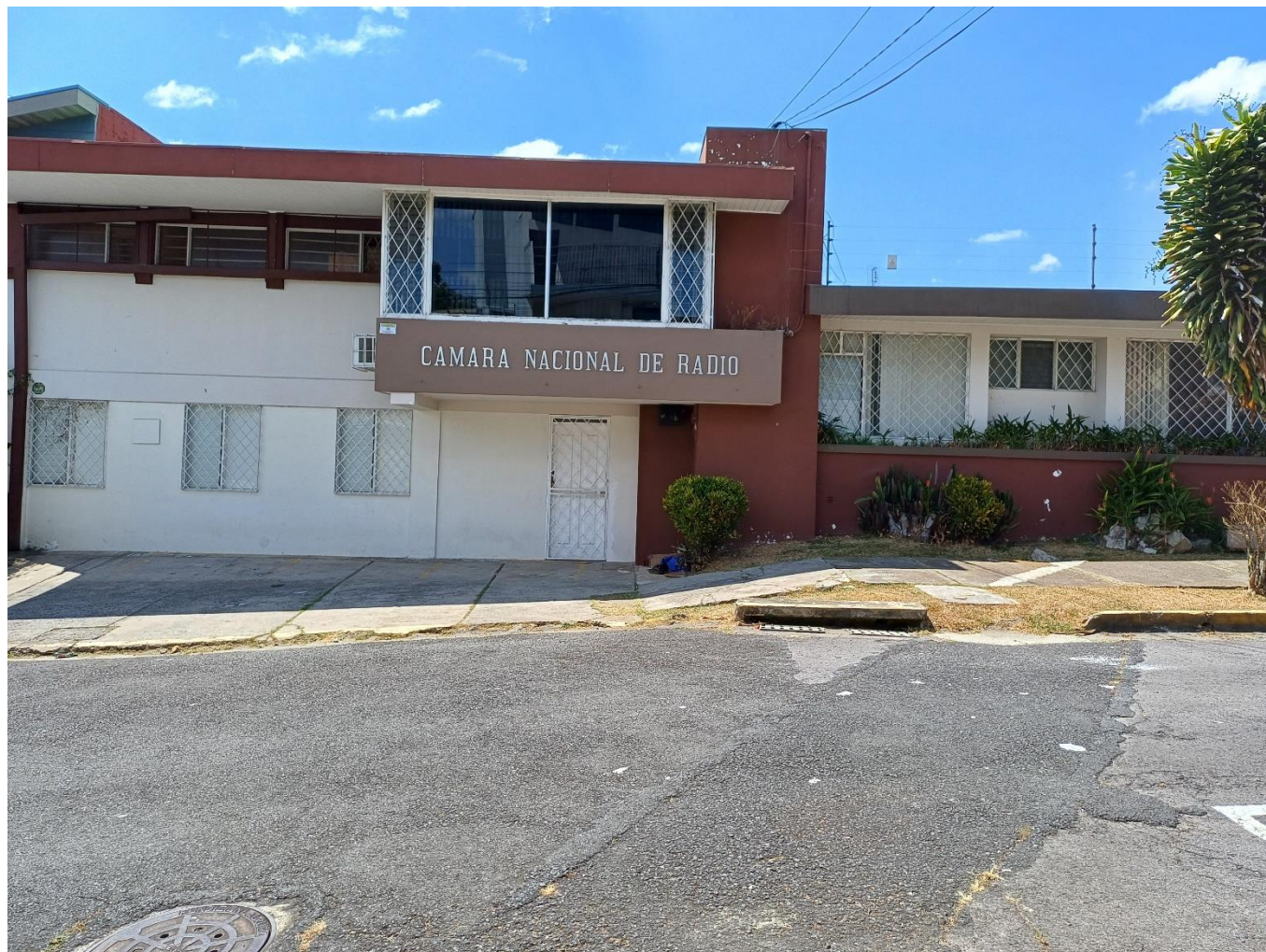
Fotografía número 3. Instalaciones de la Cámara Nacional de Radiodifusión (CANARA), ubicadas en San José. Fuente: Elaboración propia, 2024.
