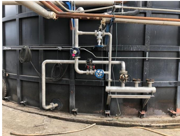
Ilustración 5. Construcción de tuberías de líquido a alta presión
