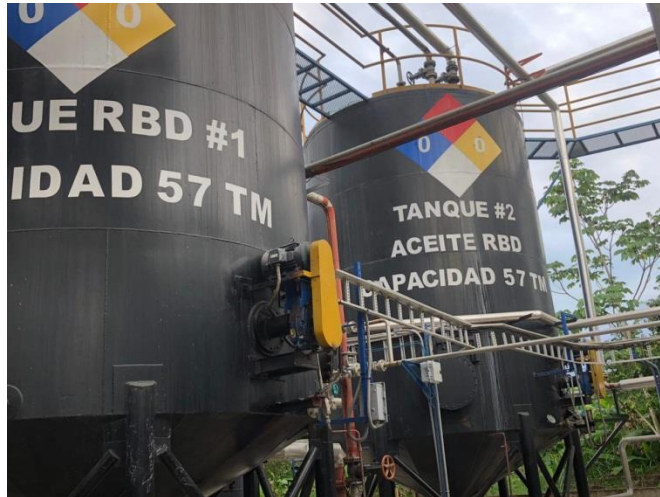
Ilustración 2. Construcción de tanques.
