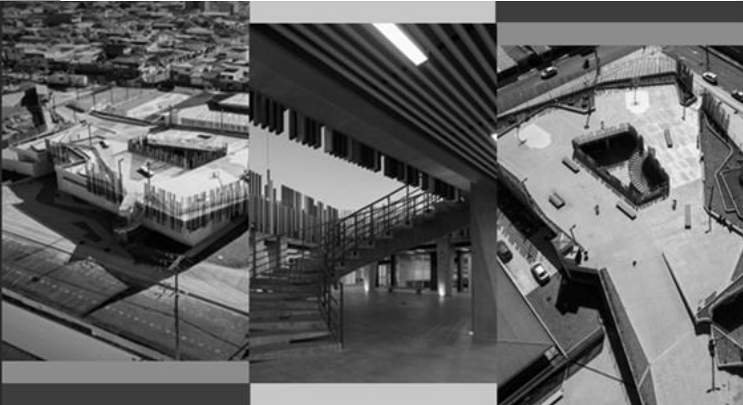
Ilustración 1, Propiedad Nortedur Arquitectos, Tomada 2022
