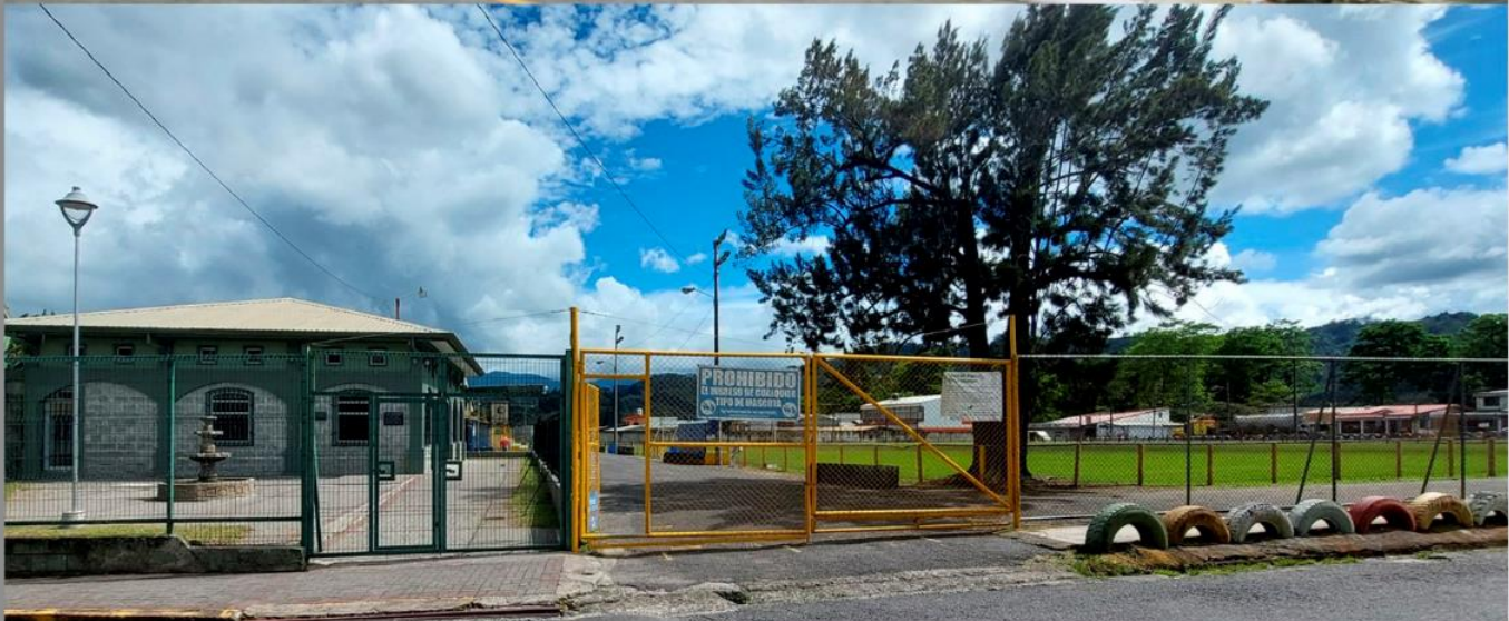
Ilustración 22, Estado Actual Lote C, Propiedad Personal, Tomado 2022
