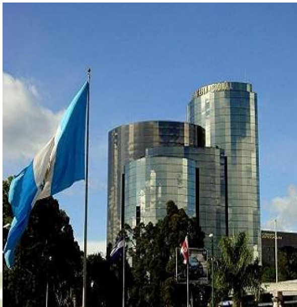
Figura 15: Torre internacional en Guatemala
