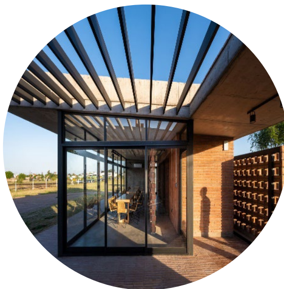
Ilustración 39- Centro comunitario San Ignacio, Argentina - Fotografías: Gonzalo Viramonte
