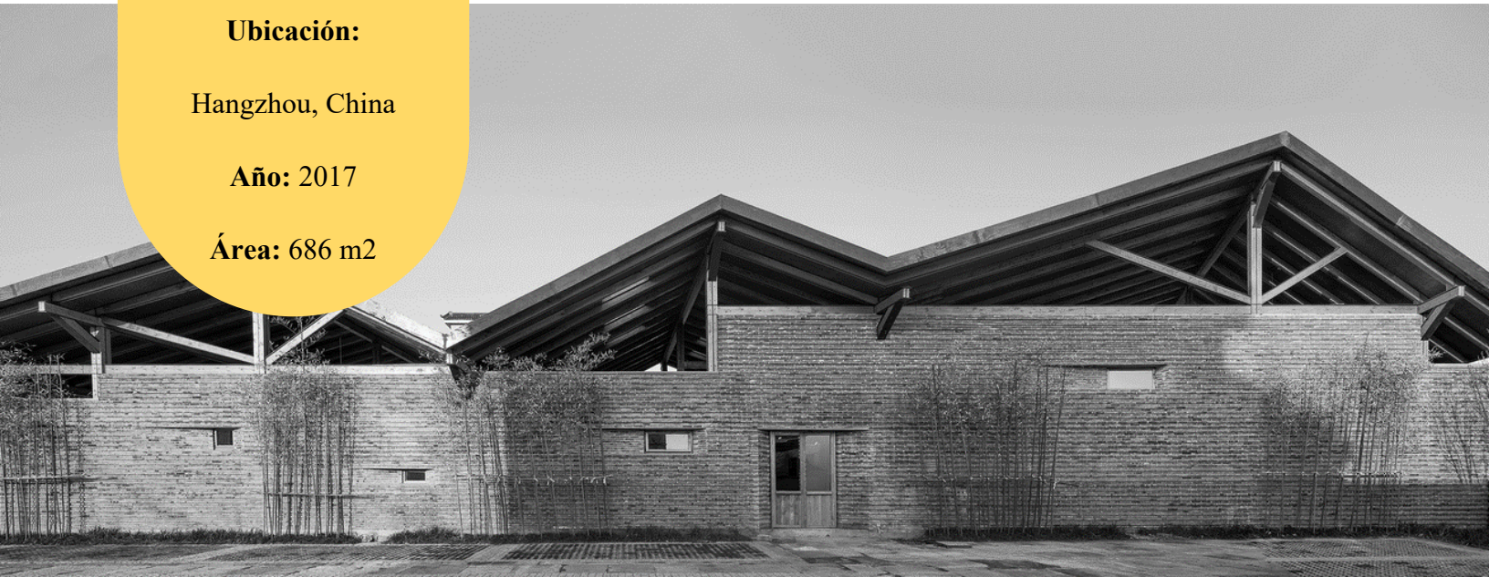
Ilustración 9- Dongziguan Villagers Activity Center – Fuente: Arch Daily
