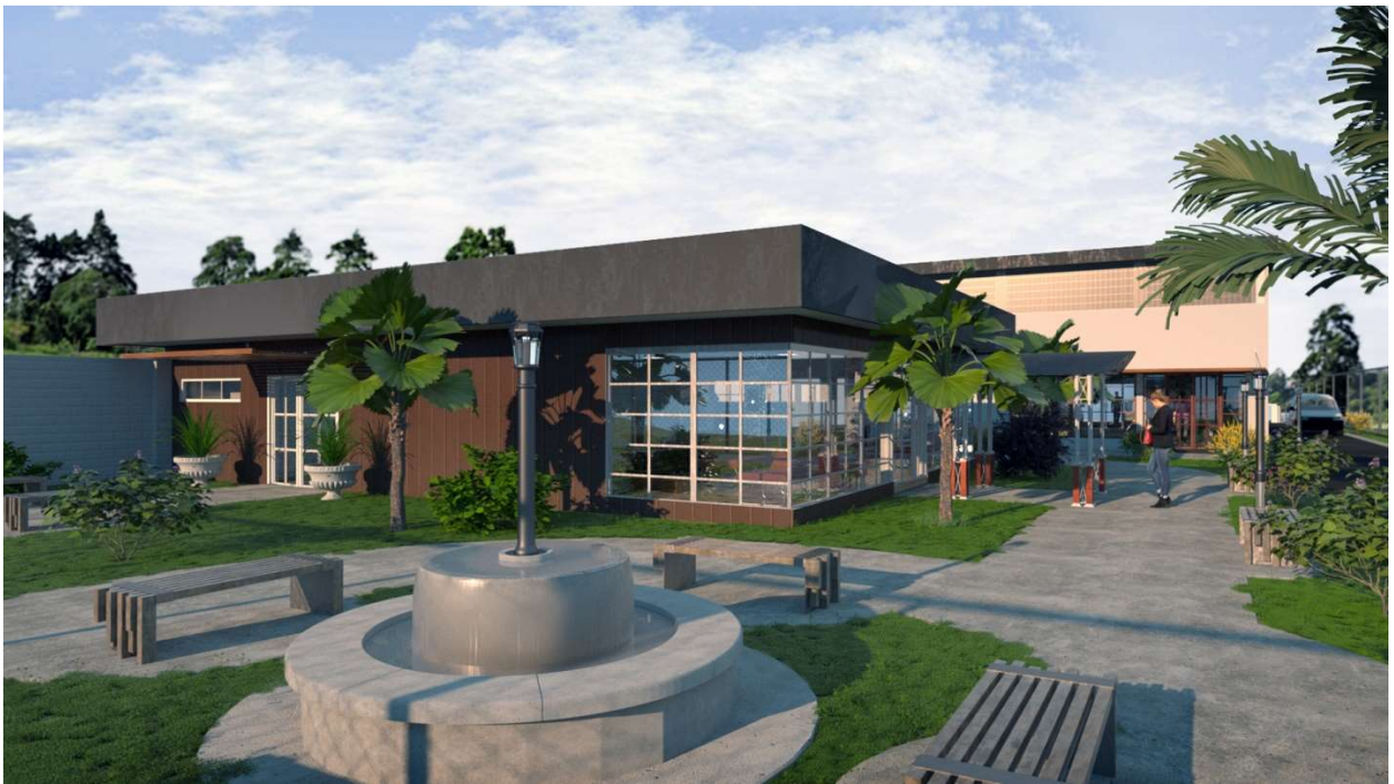
Figura 8 Vista exterior trasera del complejo
