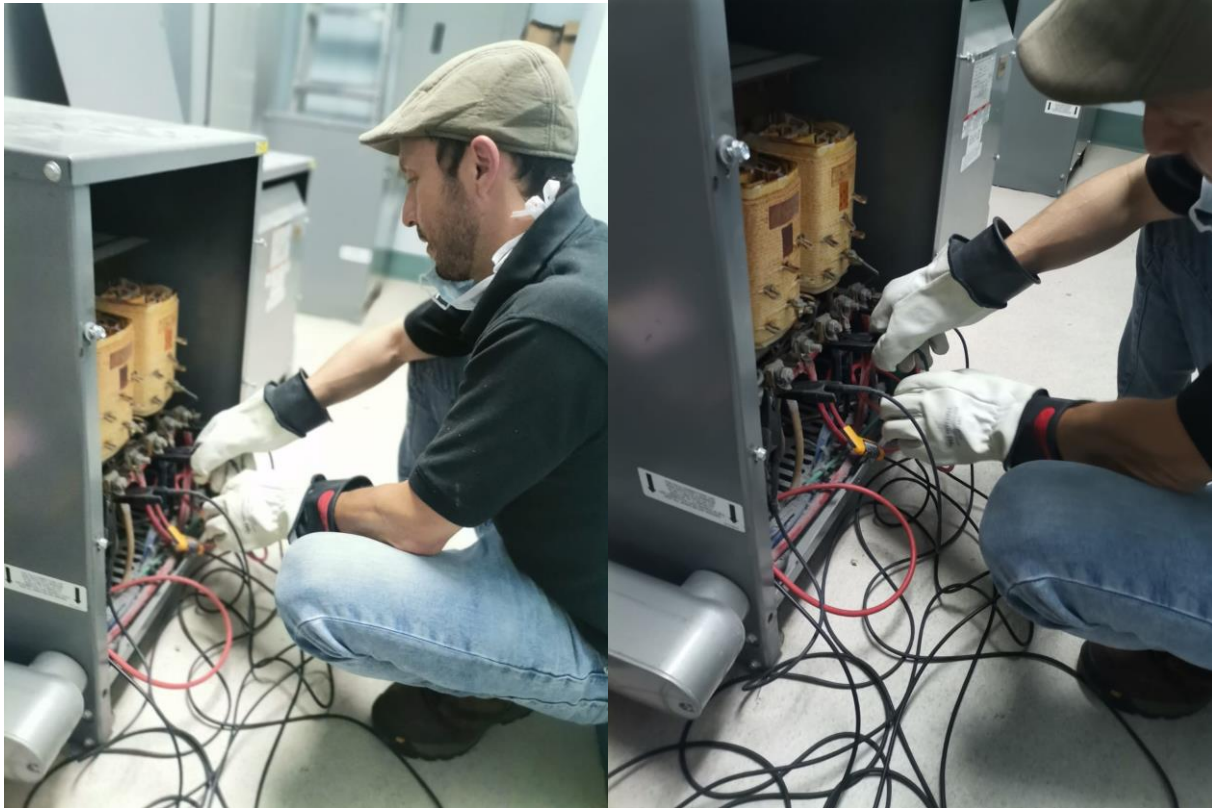
Figura 35: Colocación de analizador
