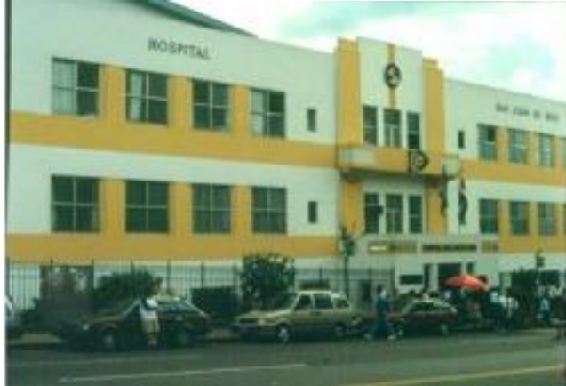
Hospital San Juan de Dios Época Constructiva: 1851-1900 Estilo: Neoclásico
