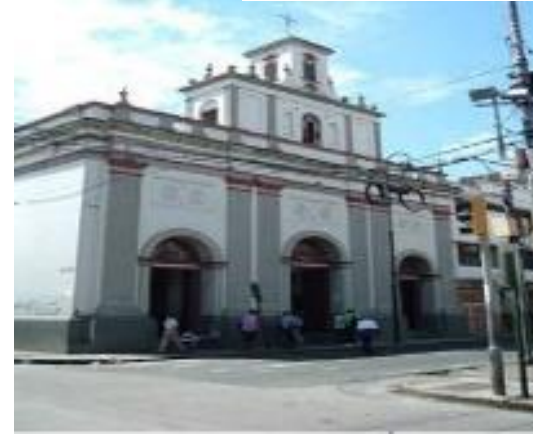
Iglesia Nuestra SRA del Carmen Época Constructiva: 1851-1900
