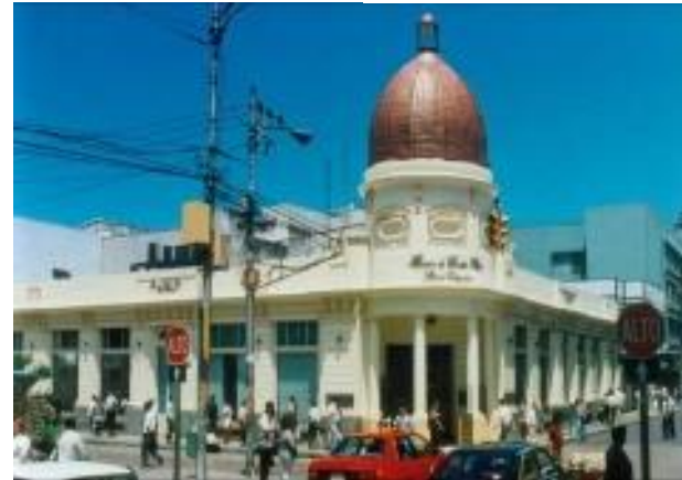
Edificio Luis Oller Época Constructiva: 1901-1950 Estilo: Neoclásico
