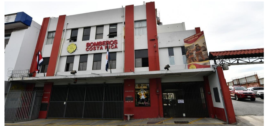
I-I 18. Estación Central
