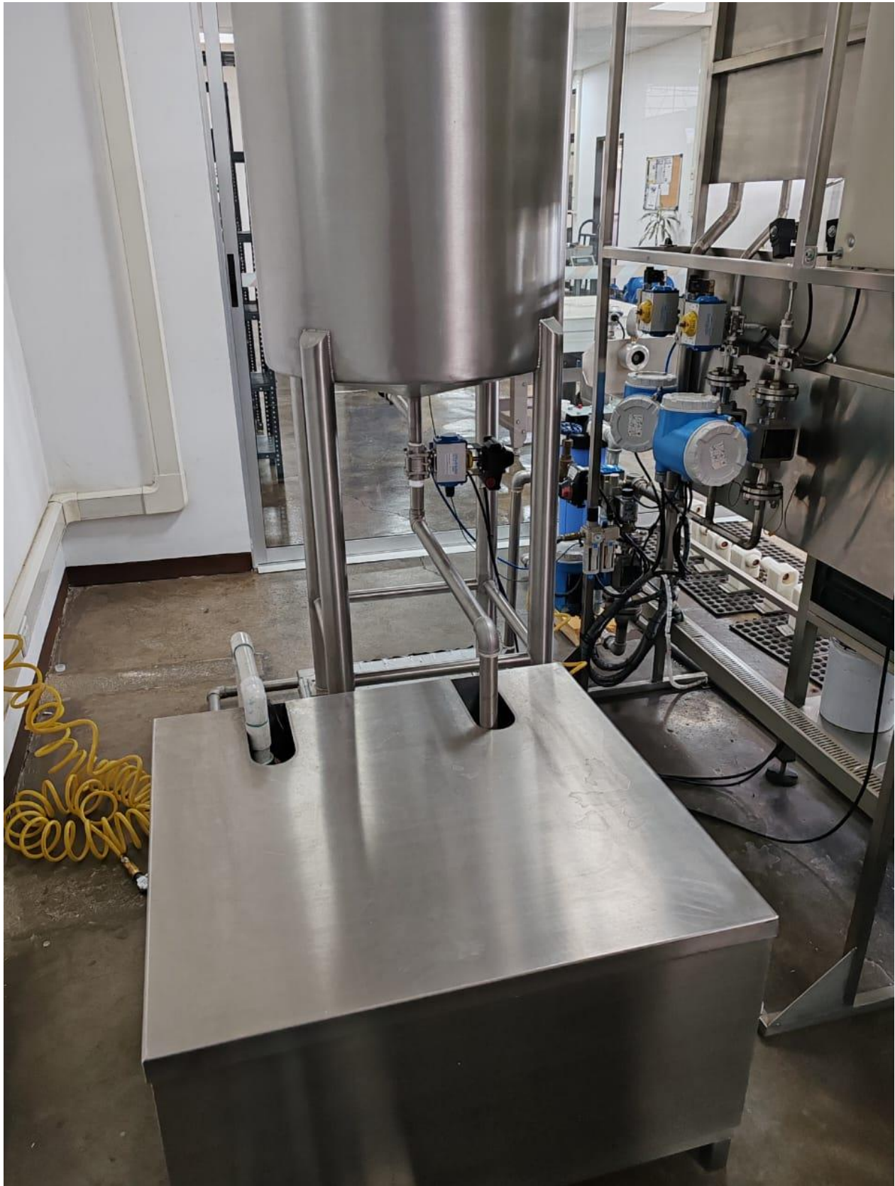
Anexó 9. Tanque de medición y tanque de captación de sólidos.
