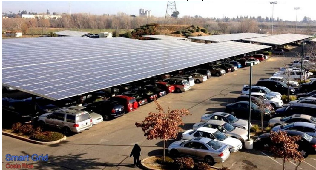
Figura 4.20: Instalación de módulos fotovoltaicos en el parqueo
