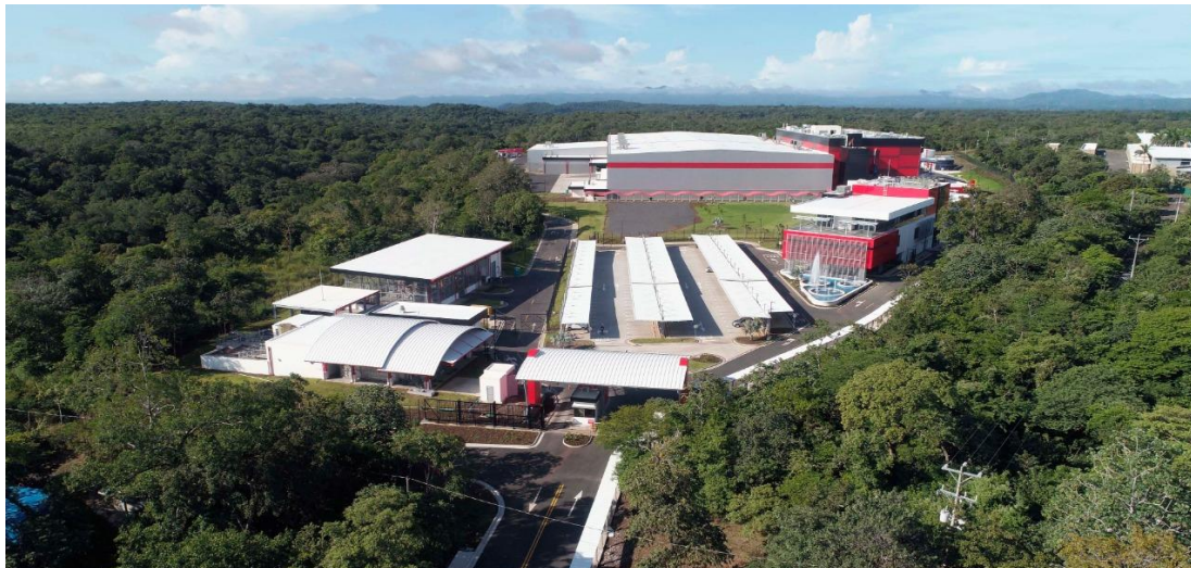
Figura 1 Vista aérea entrada este Coca-Cola Liberia
