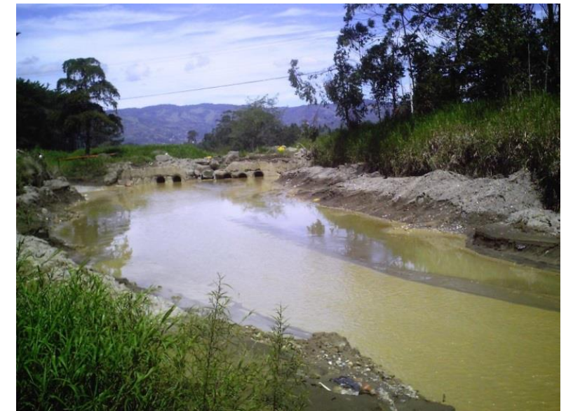
Rio reventado, dentro del área de los Diques Panoramio www.panoramio.com
