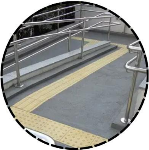
Figura 99, Rampa, Fuente: Viva Decora
