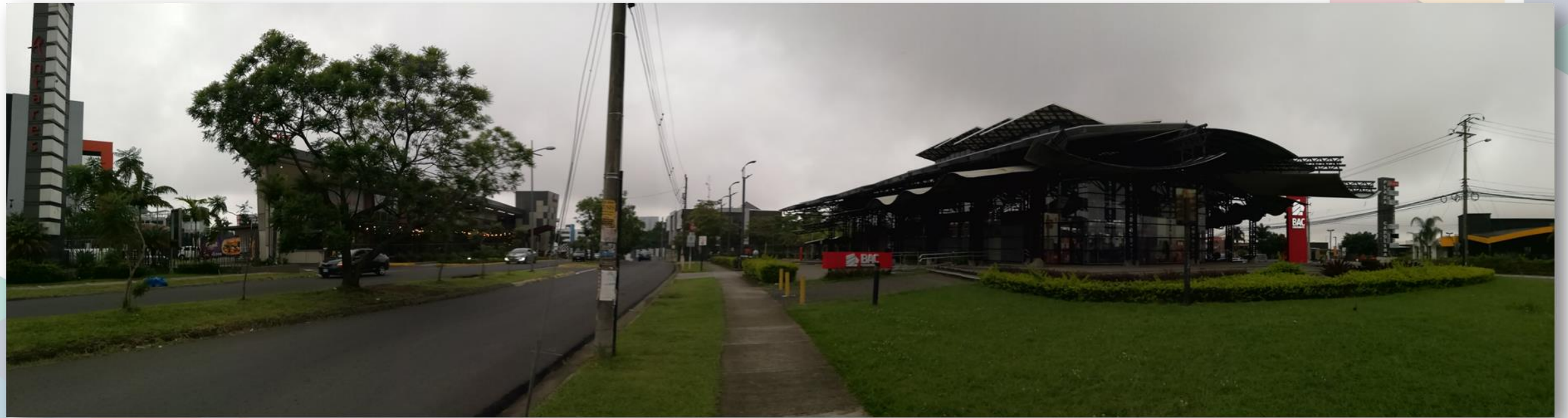
Figura 4 I: Panorámica Plaza Antares - BAC San José.
