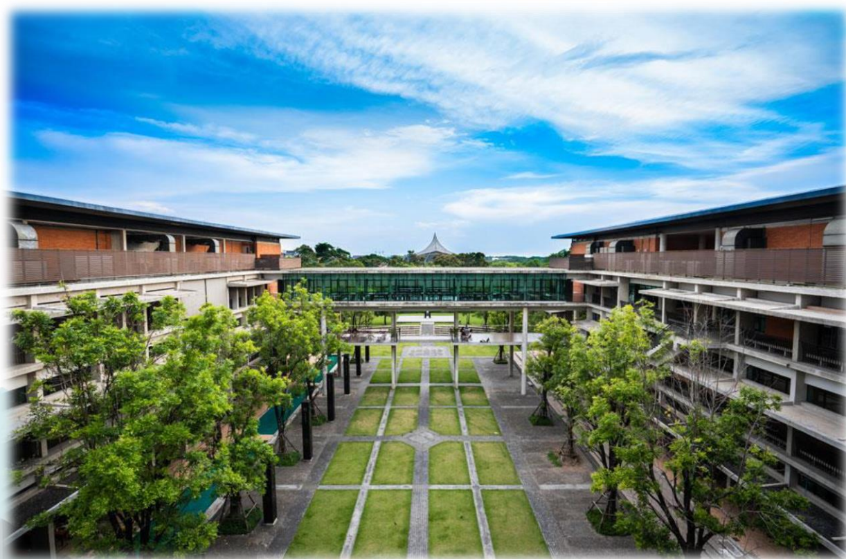
Figura 3. Vista interna de las inmediaciones del Centro de Aprendizaje de la Universidad de Mahidol en Bangkok, Tailandia.
