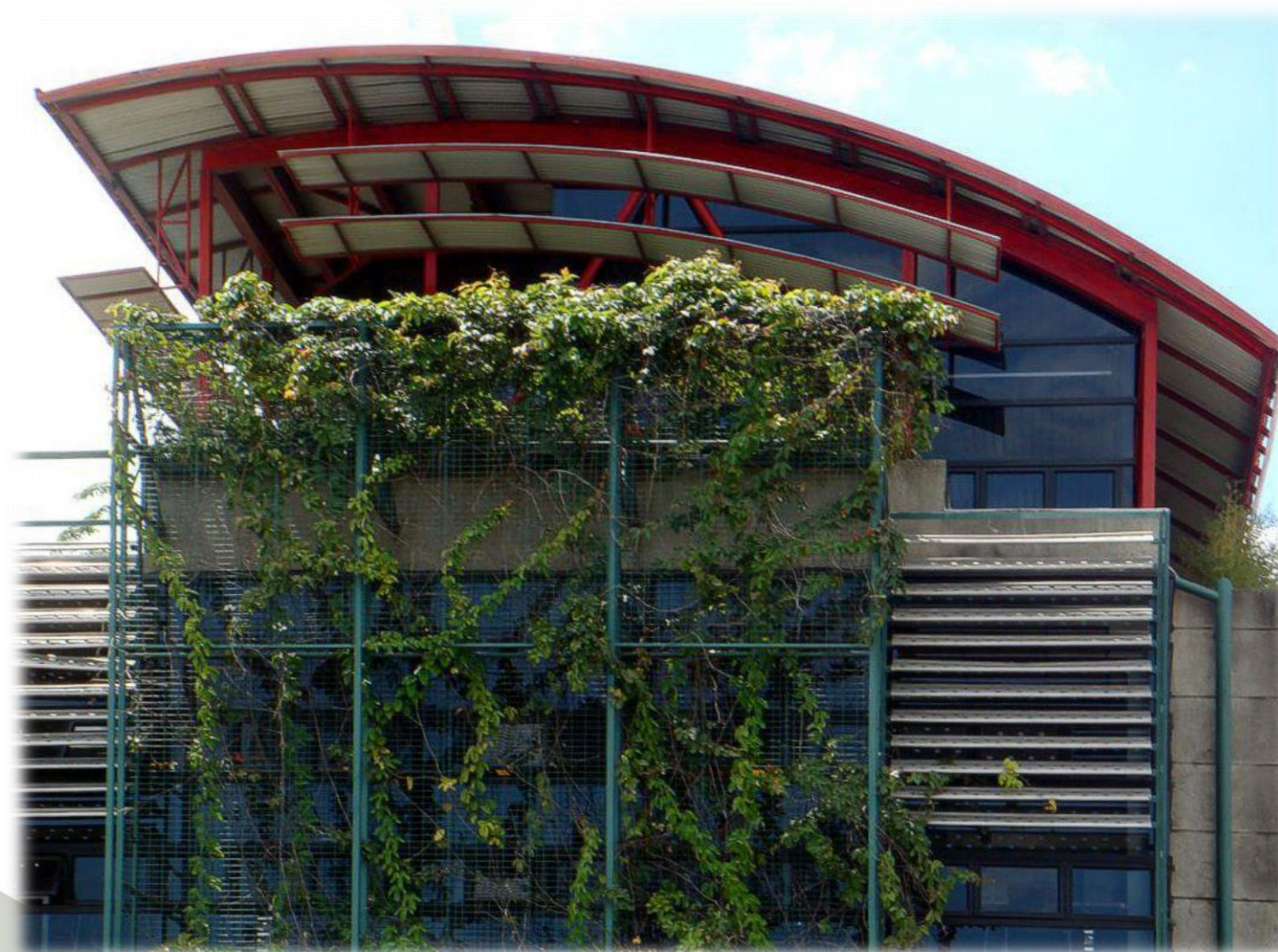
Figura 17. Vista exterior del Edificio JYR.
