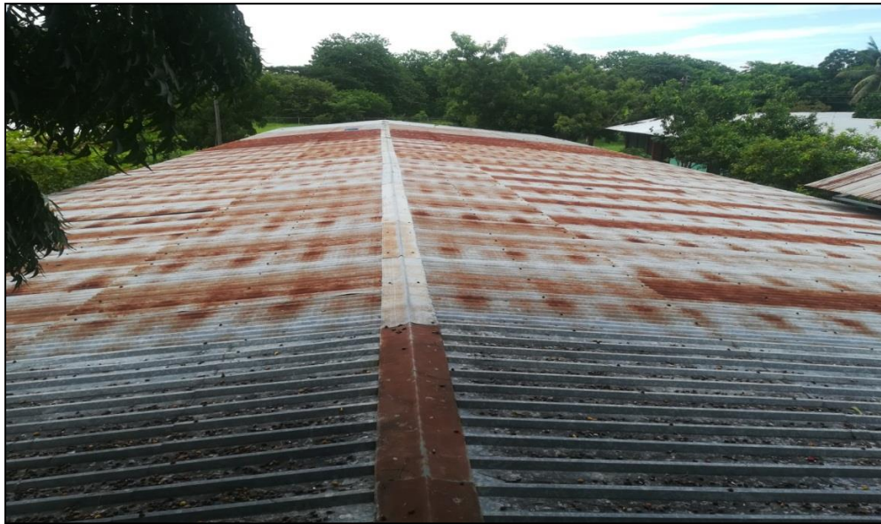
Figura 5. Vista techo pabellón D Fuente: Elaboración propia
