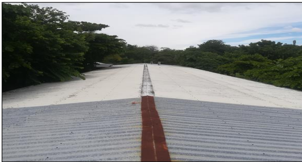
Figura 3. Vista techo zona B Fuente: Elaboración propia
