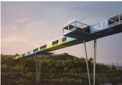
Ilustración 11. Puente de acceso con contenedores marítimos
