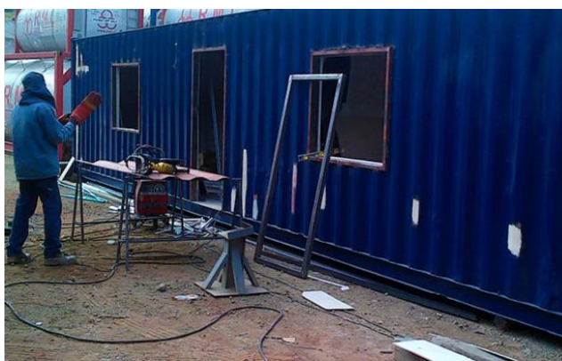
Ilustración 8. Herrería en el contenedor marítimo
