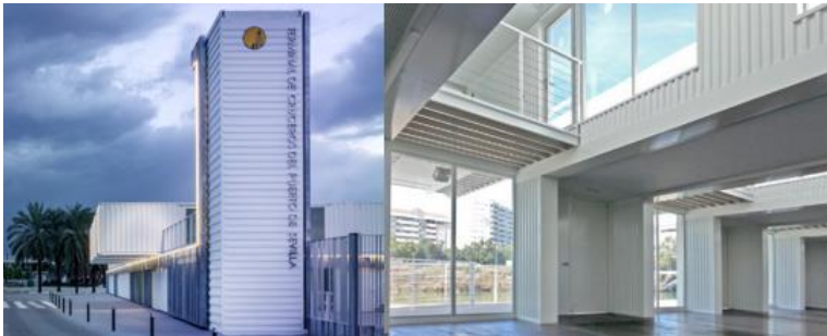
Ilustración 12. Terminal de cruceros con contenedores marítimos
