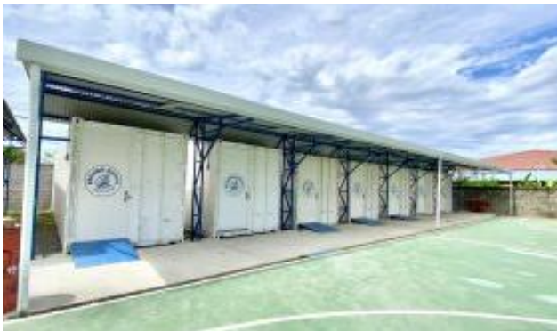
Ilustración 9. Bodegas con Contenedores Marítimos
