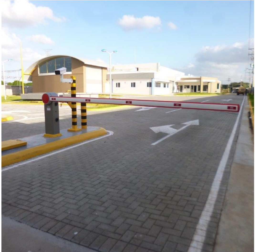
Figura 9. Vista del edificio desde el portón de ingreso.
