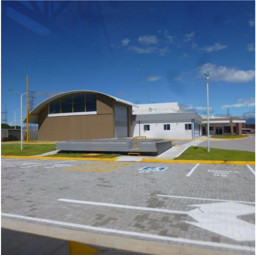
Figura 10. Fachada sur vista desde el área de parqueos.
