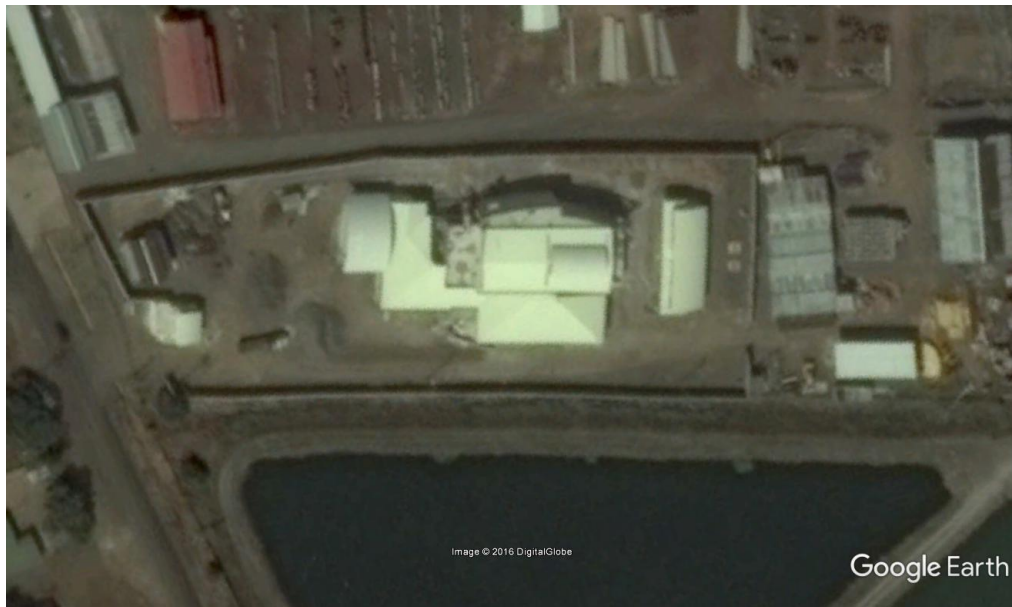
Figura 8. Vista Aérea del Proyecto (fuente: Google Earth).
