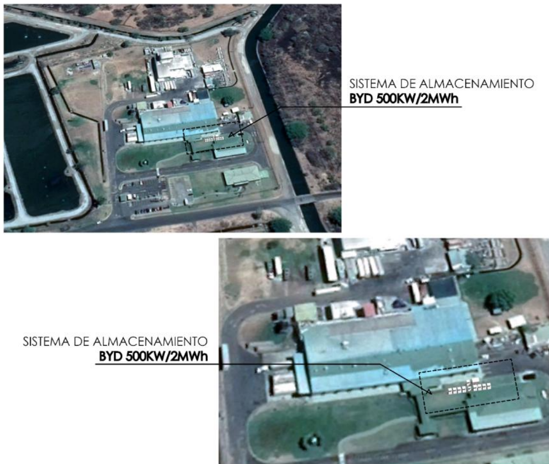
Ilustración 30. Ubicación del sistema BYD para Planta Terrapez.
