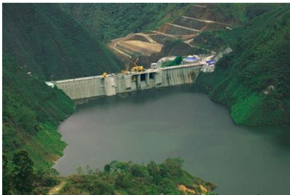
Figura 6. Represa hidroeléctrica Arenal.
