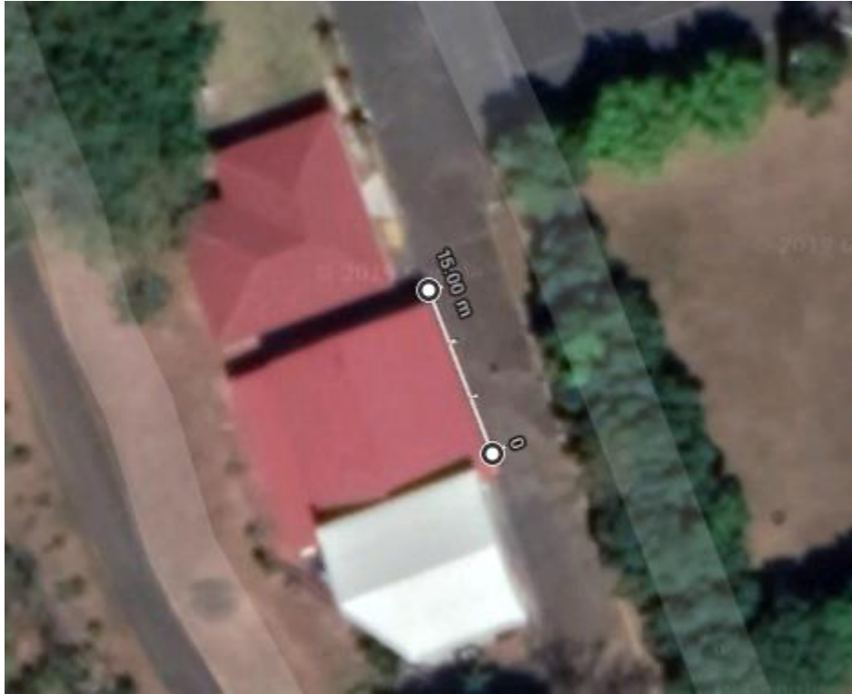
Figura 18 Ancho del techo del gimnasio. Fuente: Google Maps
