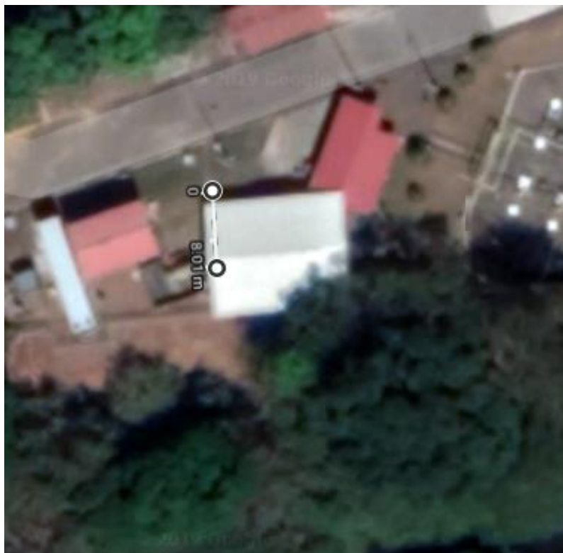
Figura 25 Largo del techo del CCM.
