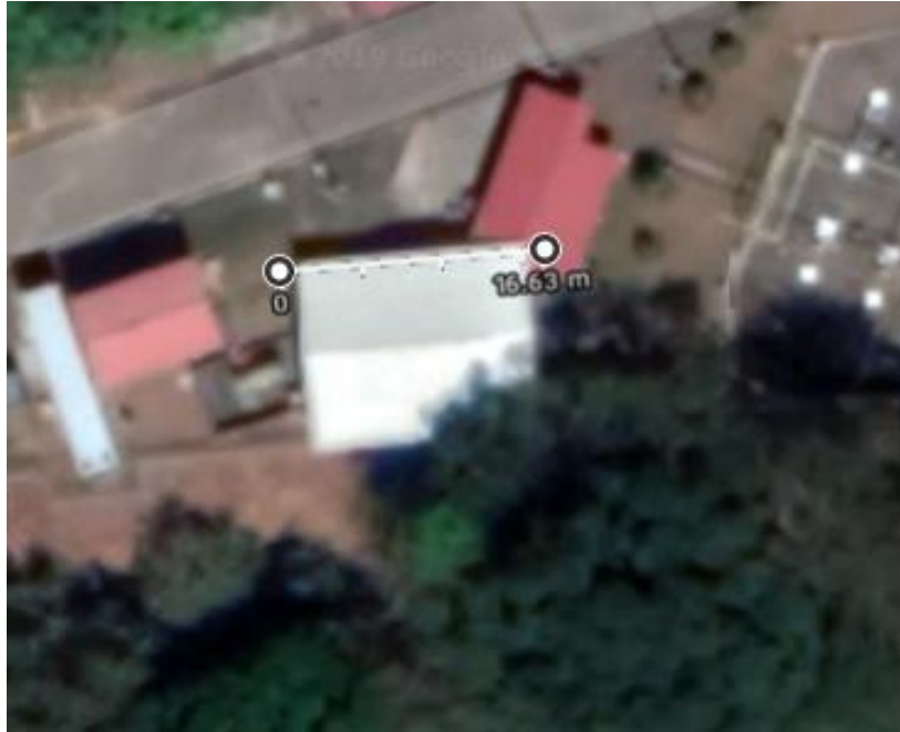
Figura 24. Largo del techo del CCM.
