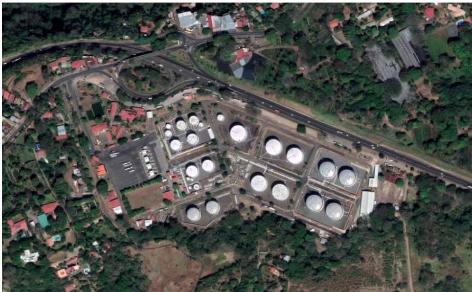
Figura 14 Vista satelital del plantel de almacenamiento y distribución de combustibles de RECOPE La Garita.
