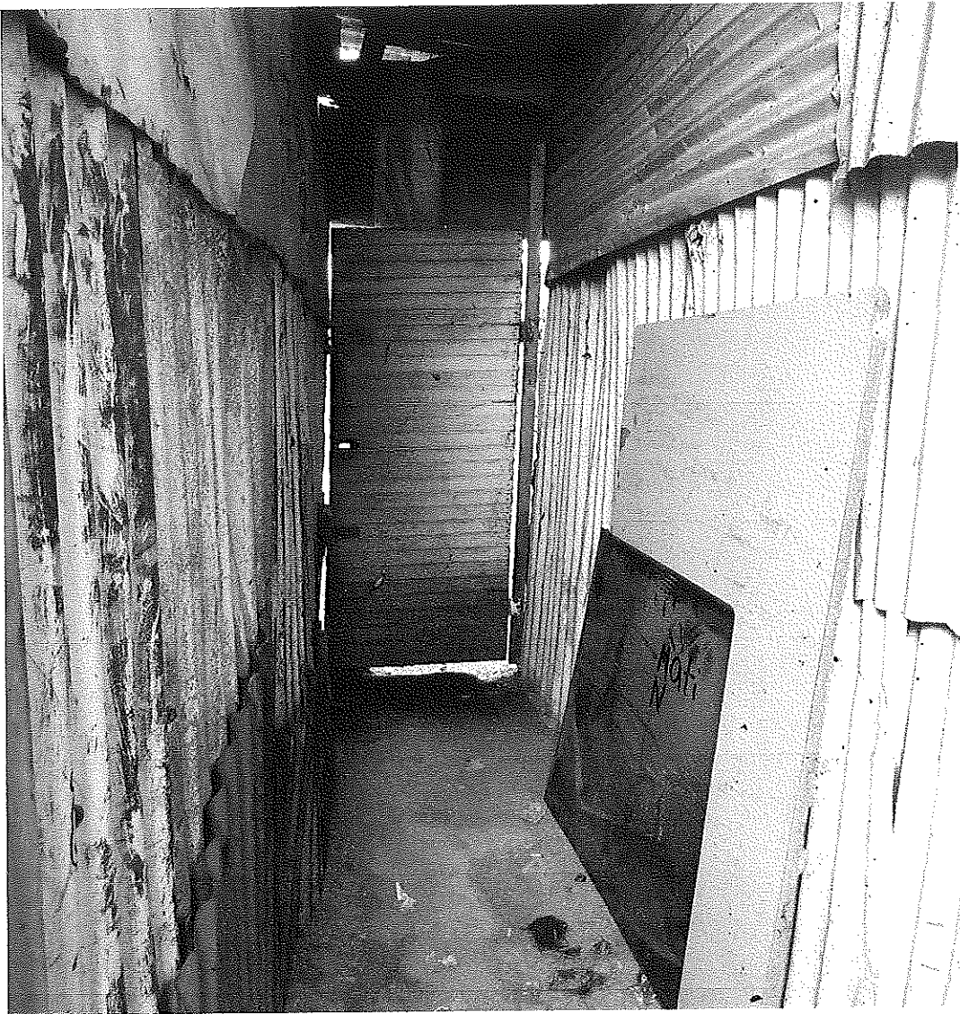
Fotografía #2. Pasillo acceso a vivienda
