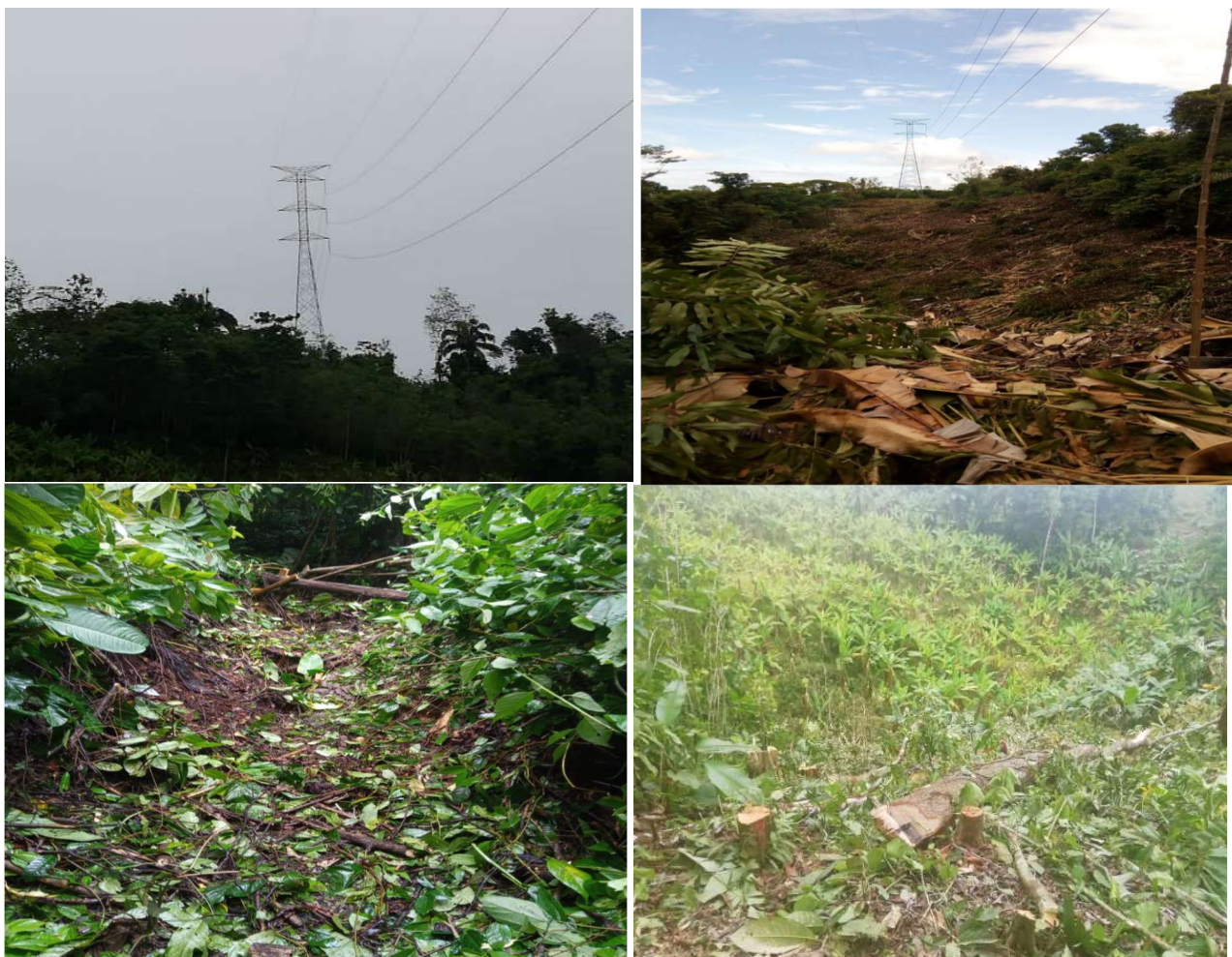
Figura 16 Registro Fotográfico EPR
