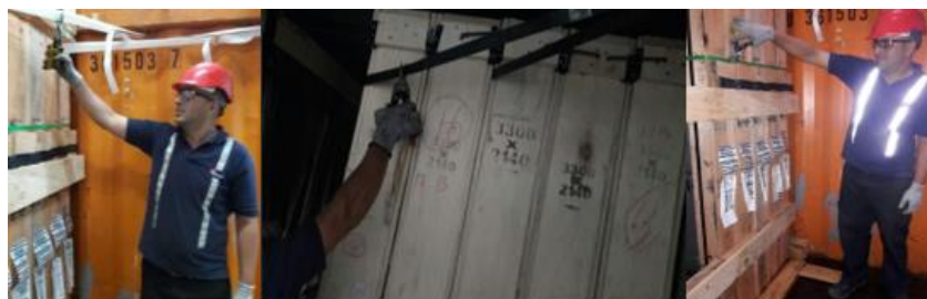
Figura 31 Corte y retiro de seguridad dentro del contenedor
